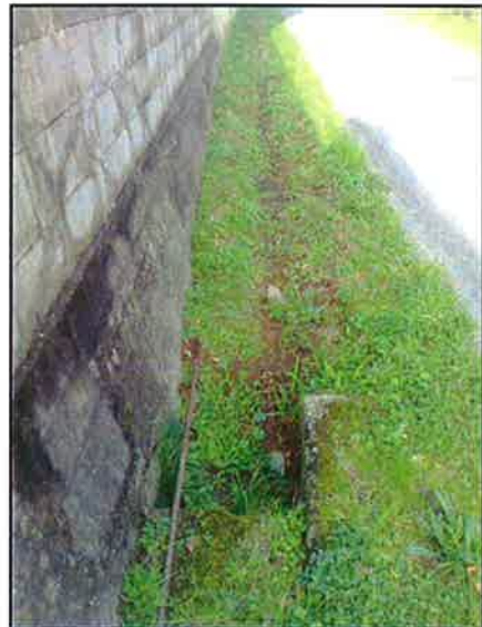
Fotografía 9 – Vista da gabia existe na marxe esquerda
