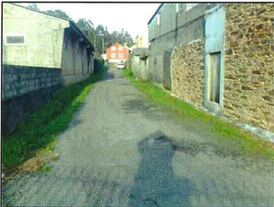
Fotografía 8 – Vista xeral da zona de actuación
