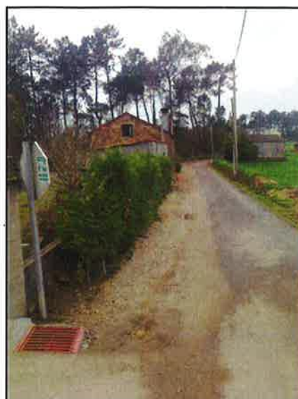
Fotografía 11 – Detalle do punto de conexión da canalización existente cō Tramo I
