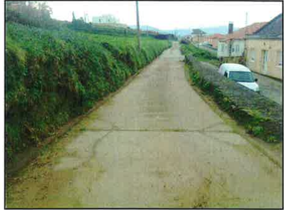
Fotografía 7 – Vista xeral da zona de implantación do canal sumideiro e arqueta
