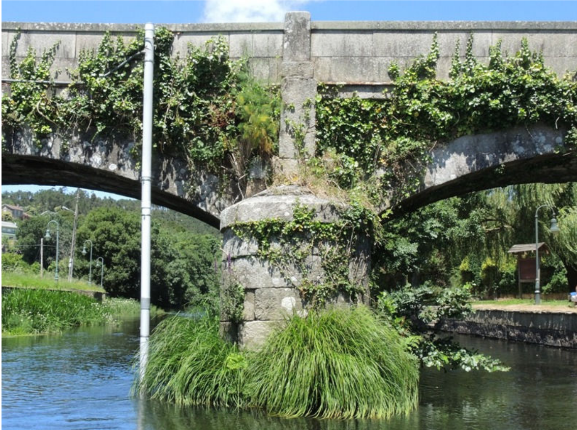
Fotografía 28.- Vista del espolón
