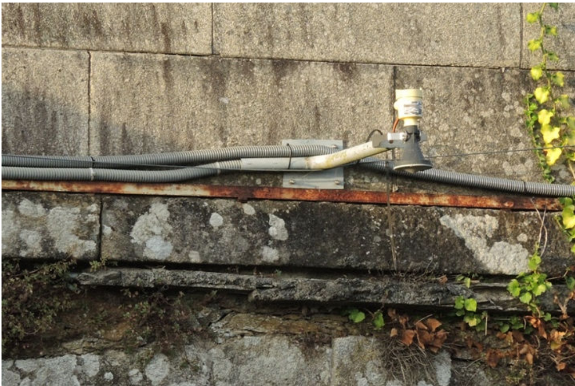
Fotografía 39.- Detalle de aparato medidor de caudales
