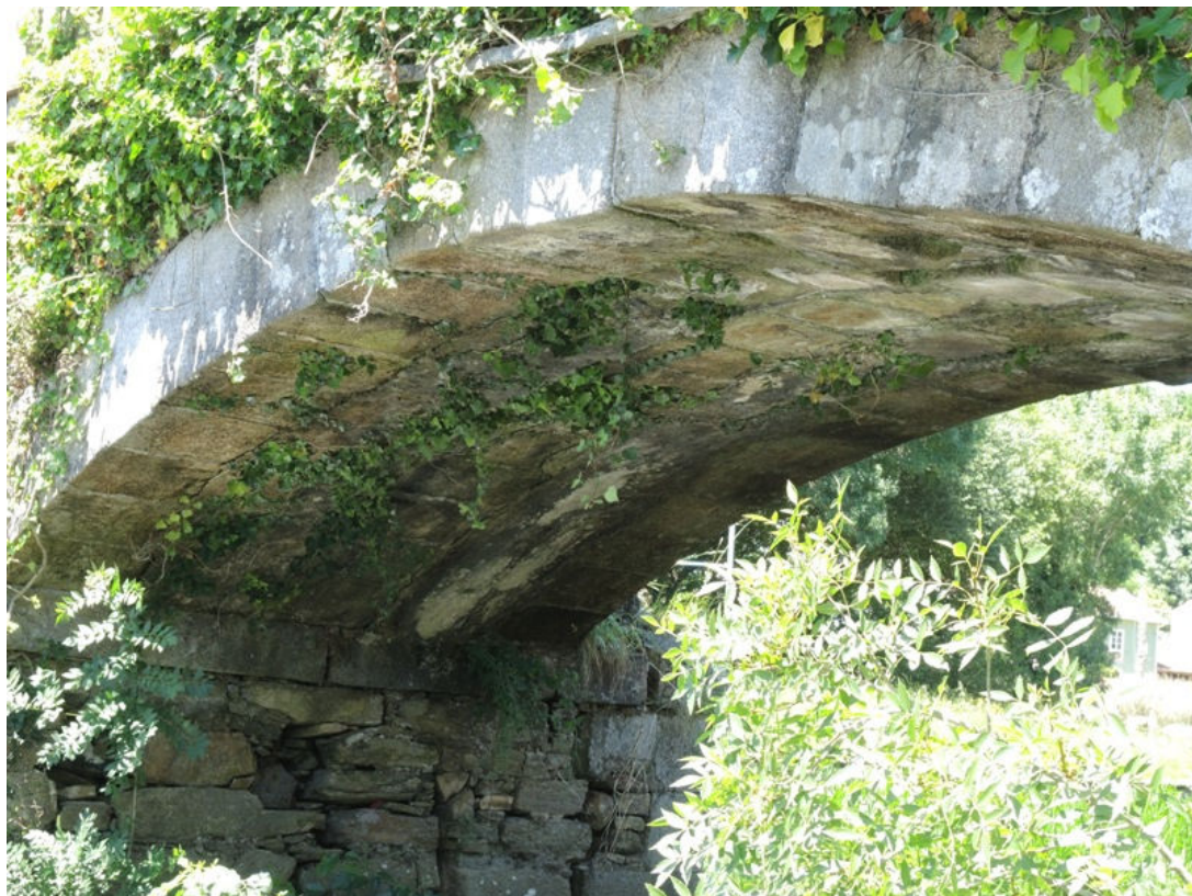
Fotografía 16.- Intradós de la bóveda izquierda desde la margen izquierda aguas abajo
