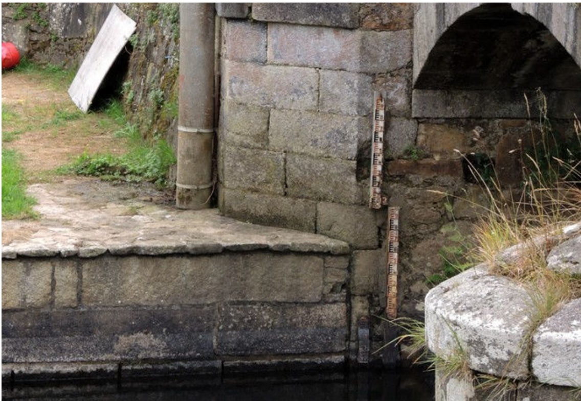
Fotografía 43.- Detalle de la escala limnimétrica
