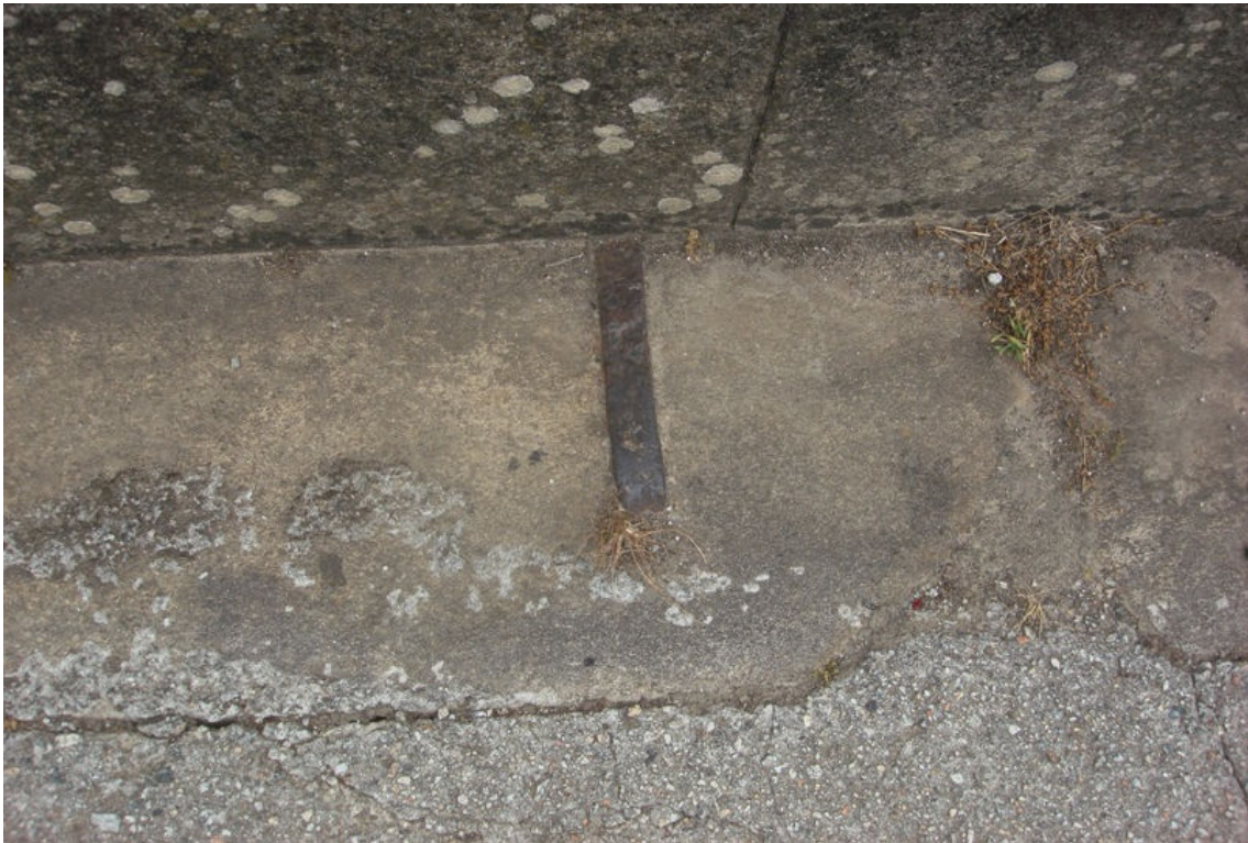
Figura 19.- Perfil metálico de refuerzo de apoyo de la sillería de los pretilos
