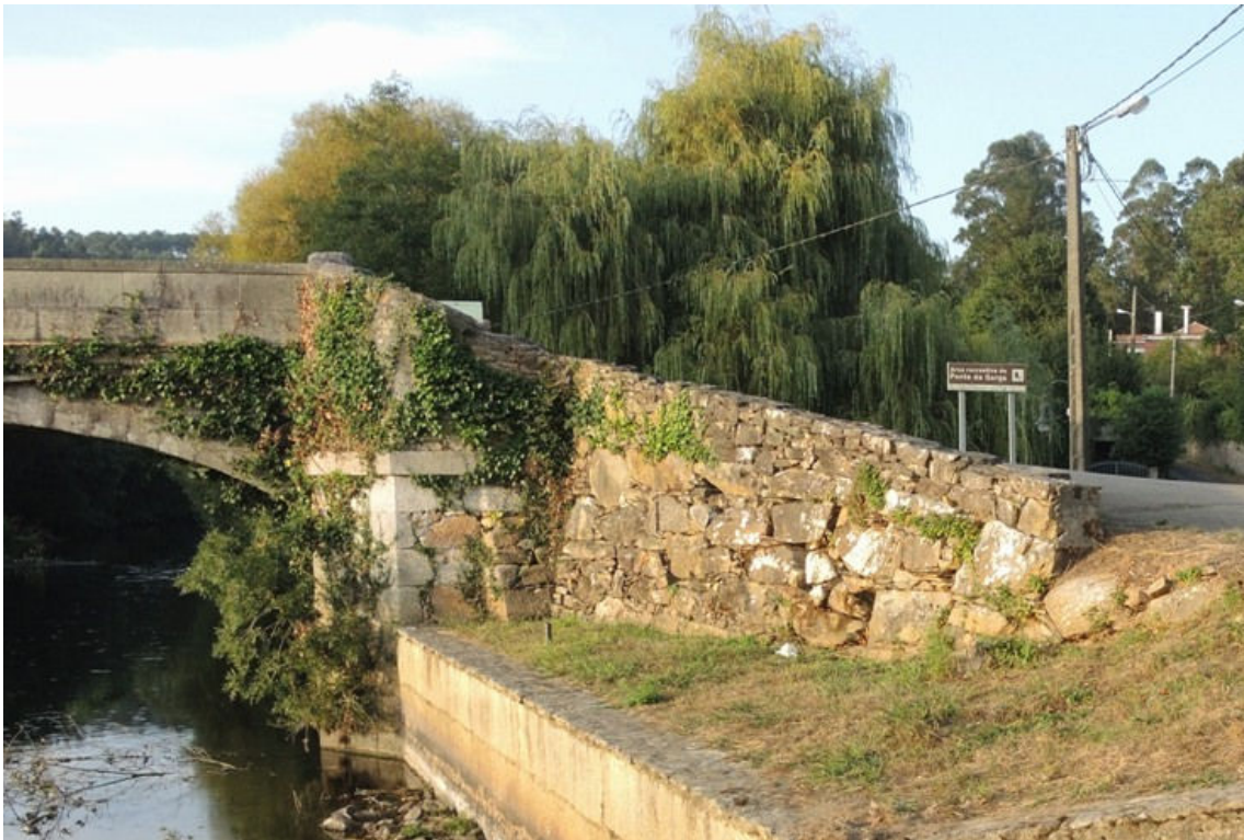
Fotografía 19.- Estribo izquierdo aguas abajo
