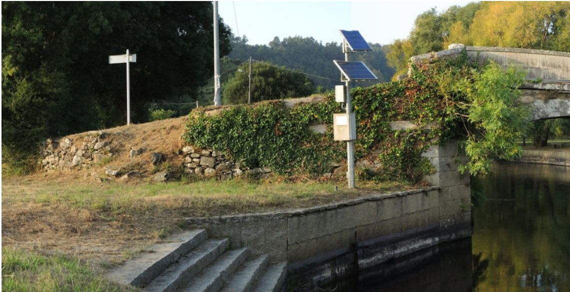
Figura 20.- Rampa de acceso del estribo derecho (vista desde aguas abajo)
