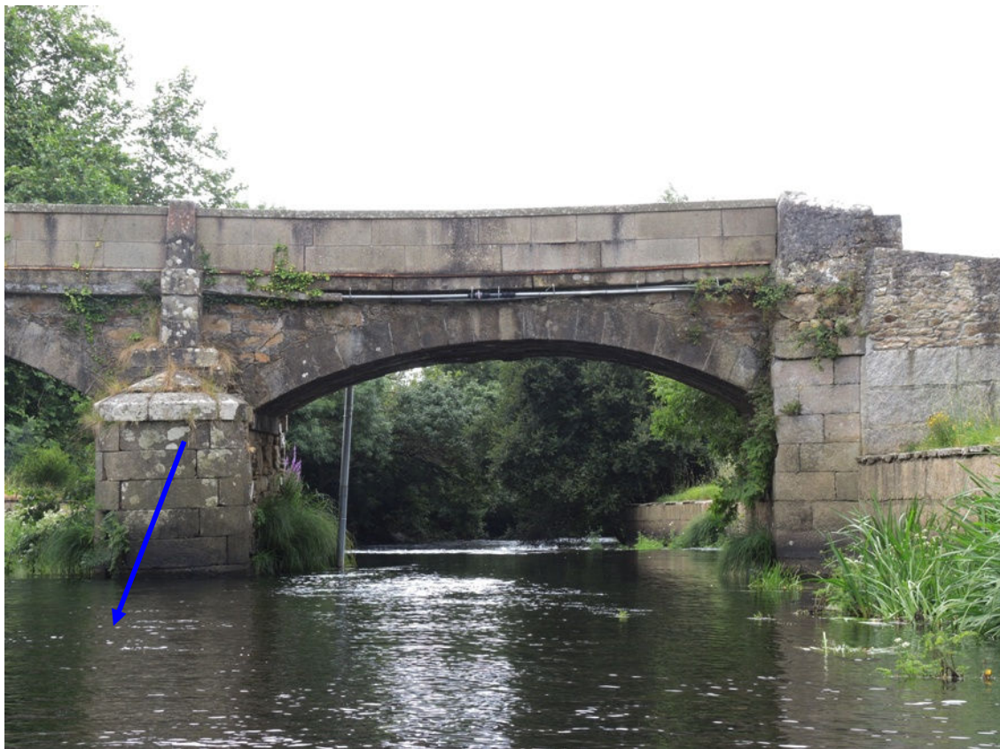
Figura 2.- Descenso y giro de la pila en su parte central
