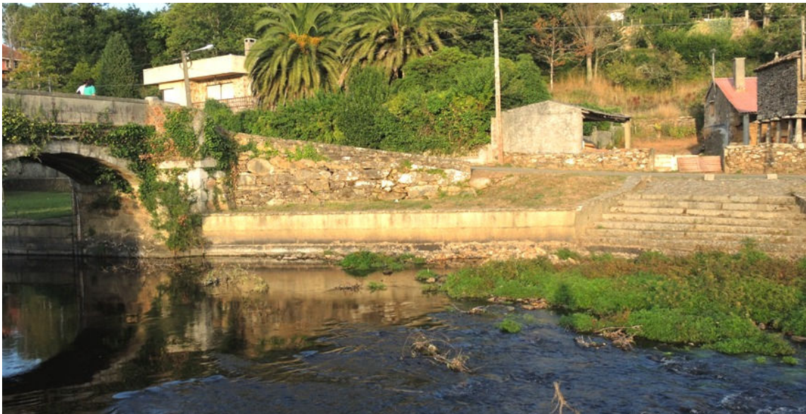
Figura 21.- Rampa de acceso del estribo izquierdo (vista desde aguas abajo)
