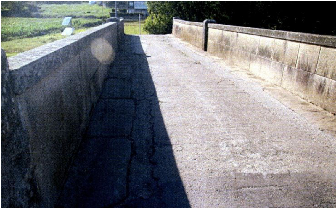
Fotografía 6.- Calzada con piezas de la cornisa vistas en ambos lados (Foto M. Doce)
