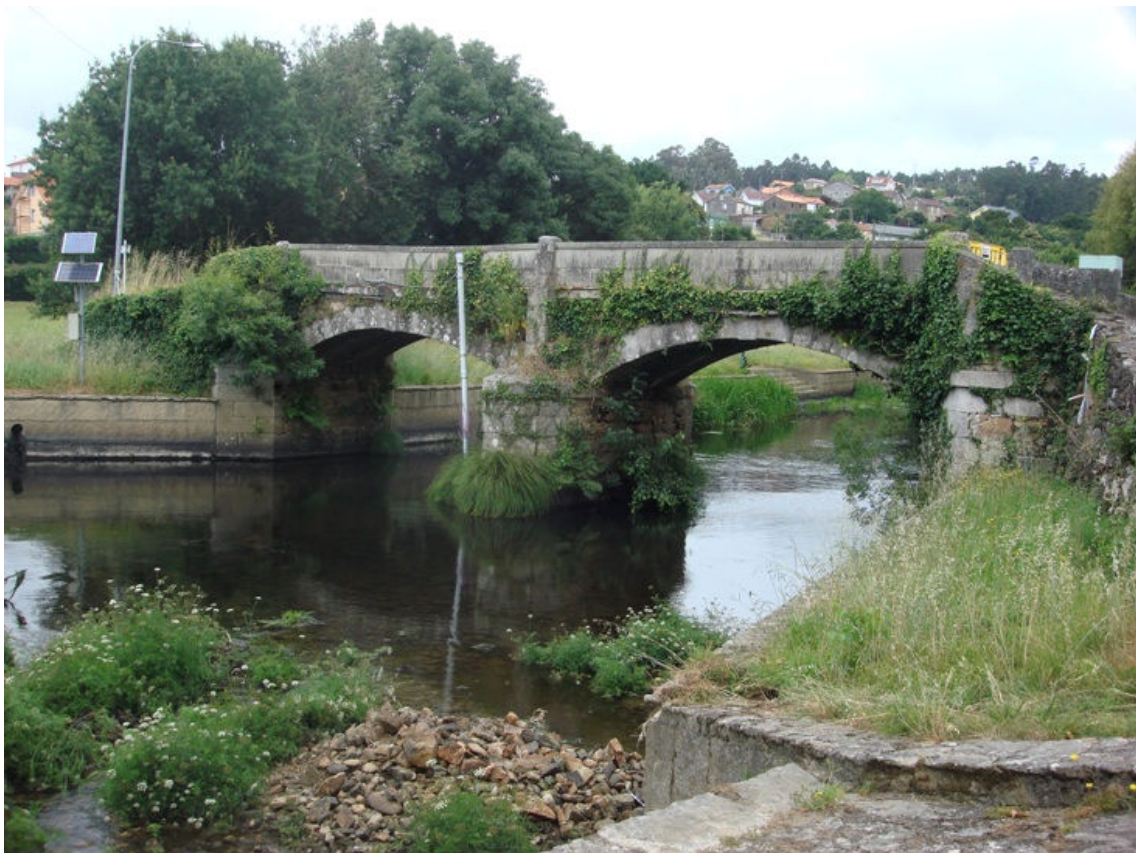
Fotografía 8.- Alzado aguas abajo
