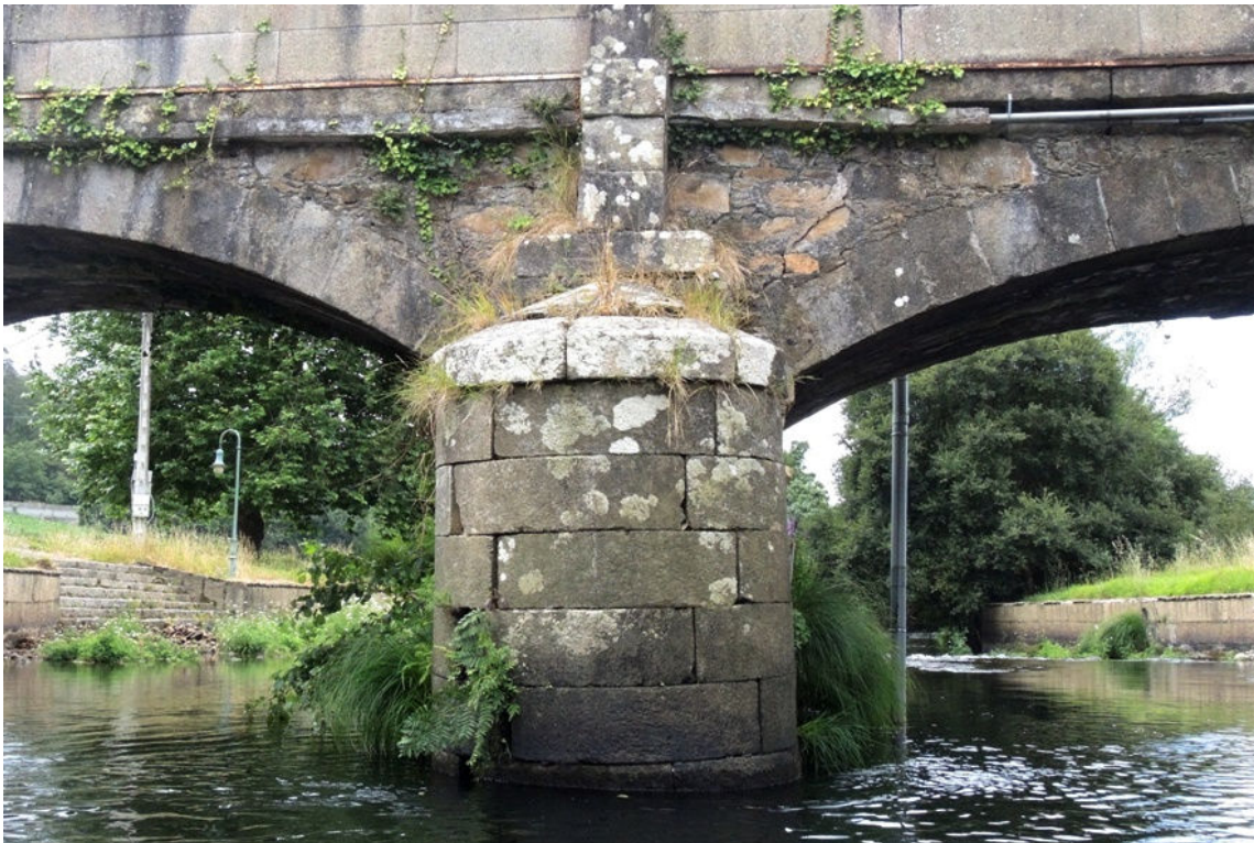
Fotografía 27.- Vista del tajamar
