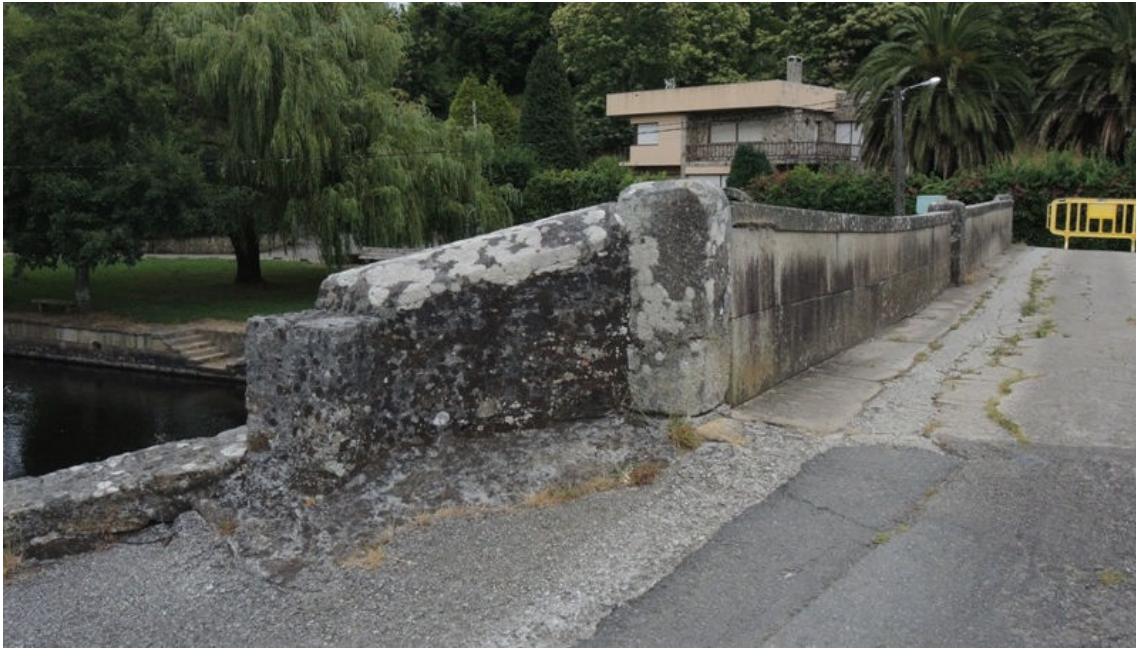
Figura 10.- Peto de la aleta aguas arriba del estribo derecho
