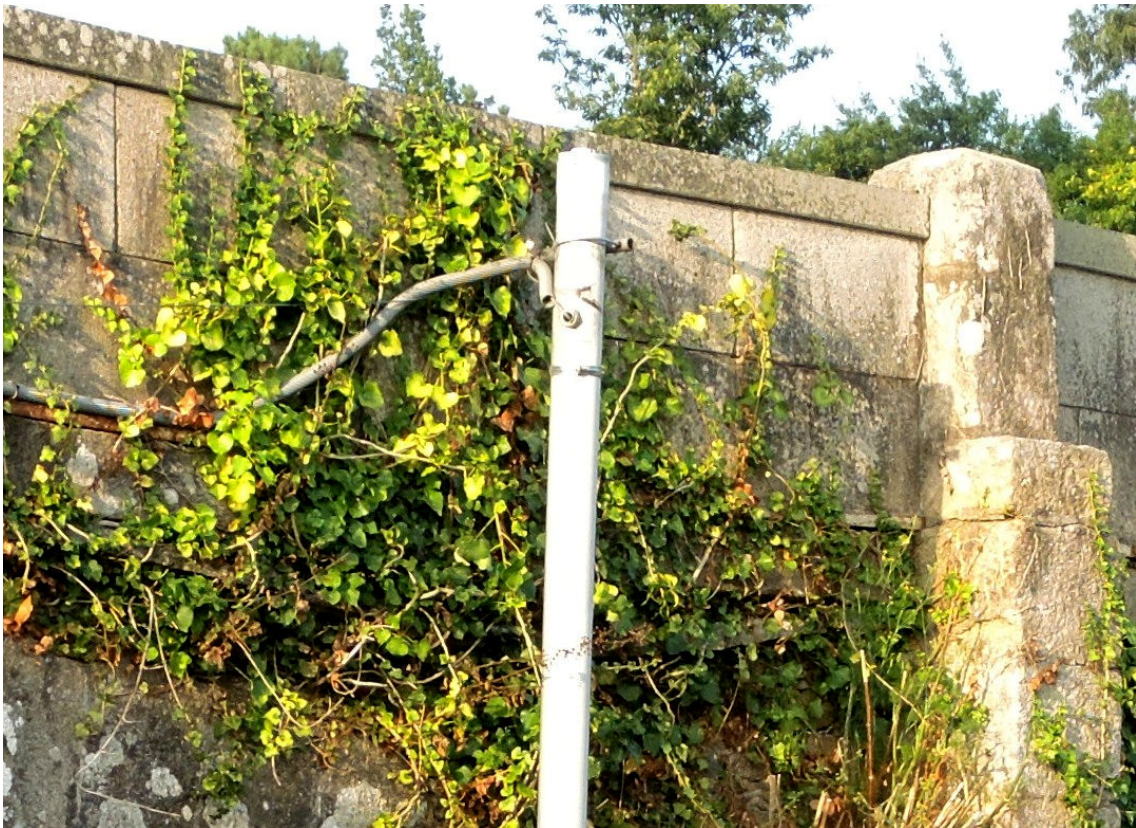
Fotografía 41.- Anclaje al prefil de la estación de aforos
