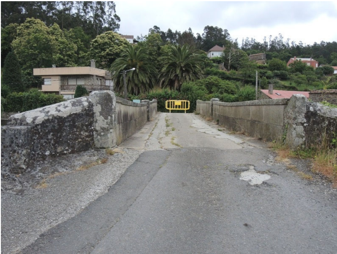
Figura 15.- Calzada y pretils
