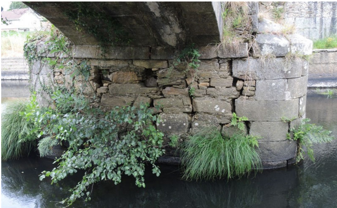
Figura 11.- Cuerpo central de la pila de mampostería irregular (vista desde margen izquierda)
