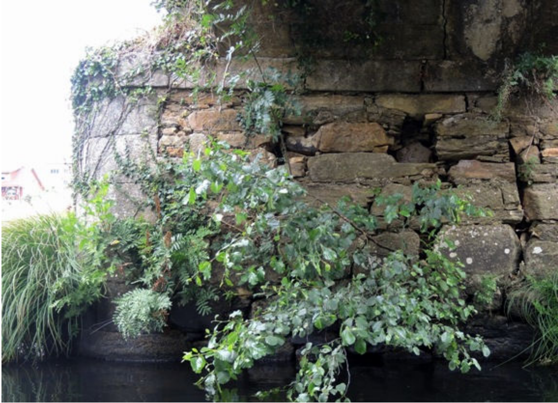
Fotografía 26.- Paramento de la pila bajo el arco izquierdo
