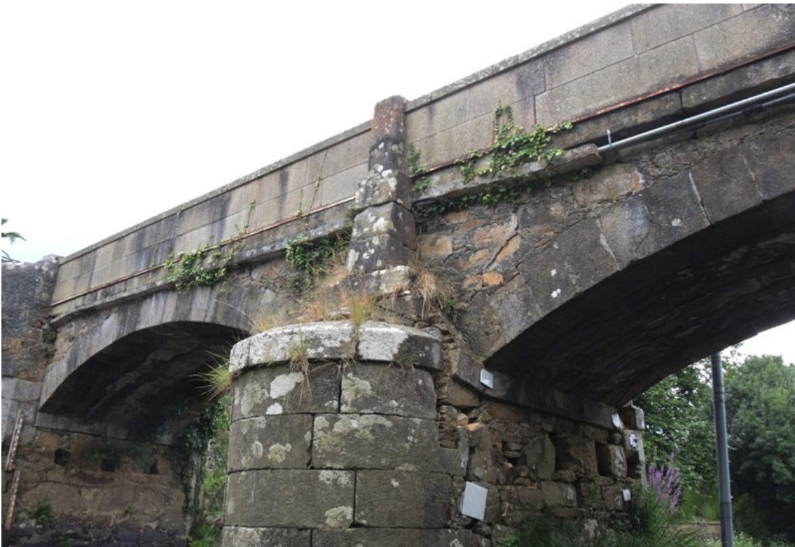
Fotografía 29.- Parte superior del tajamar
