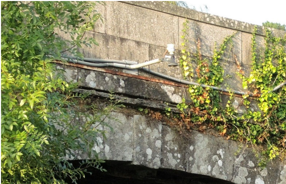
Figura 23.- Aparato para aforos de caudales
