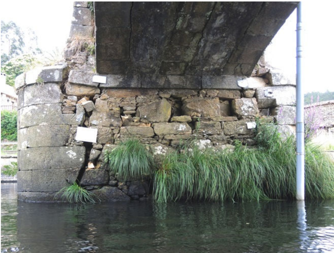
Fotografía 21.- Paramento de la pila, de mampostería muy irregular colocada en seco bajo el arco derecho
