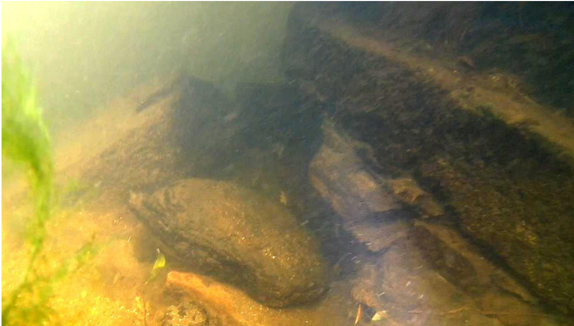
Figura 33.- Acuñado de los sillares acostados de la cimentación de la pila
