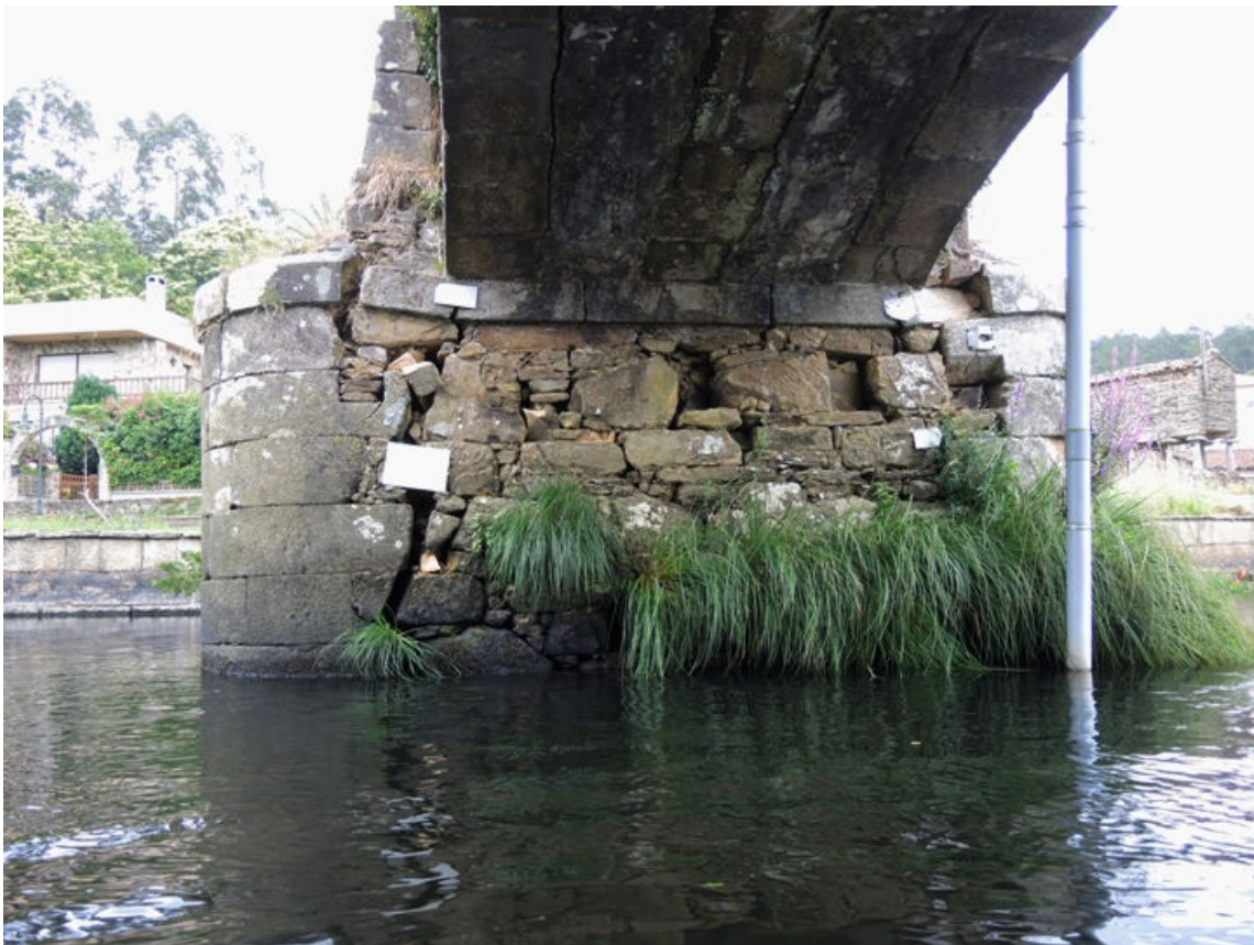
Figura 29.- Situación de la pila en septiembre de 2016
