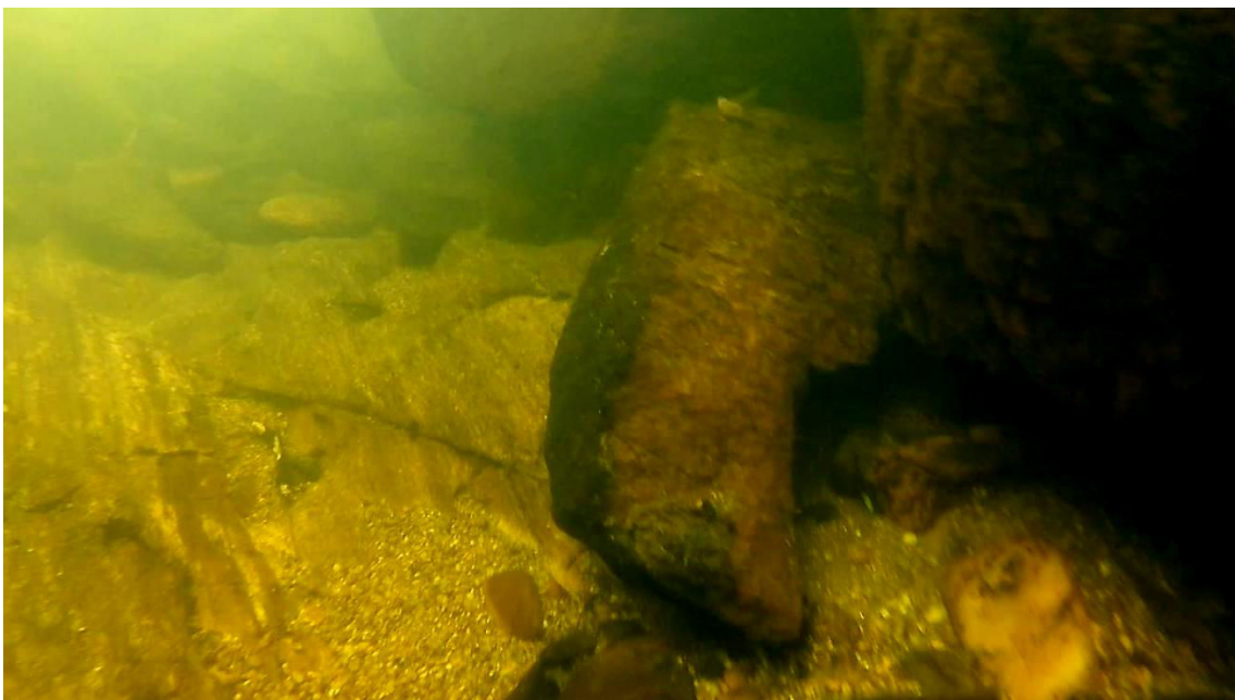
Inspección subacuática en la base de la pila central del puente
