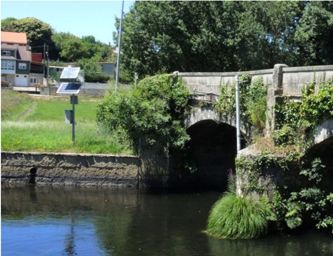
Fotografía 38.- Instalación de Augas de Galicia para medición de caudales y contaminación
