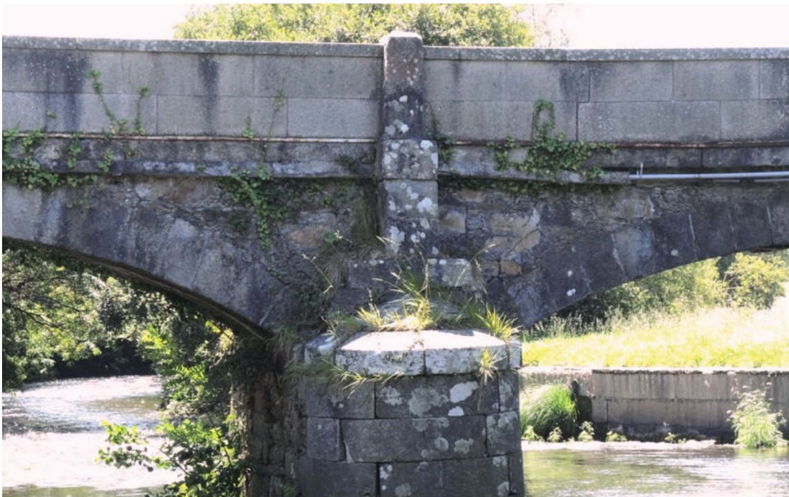
Figura 7.- Tímpanos del lado aguas arriba
