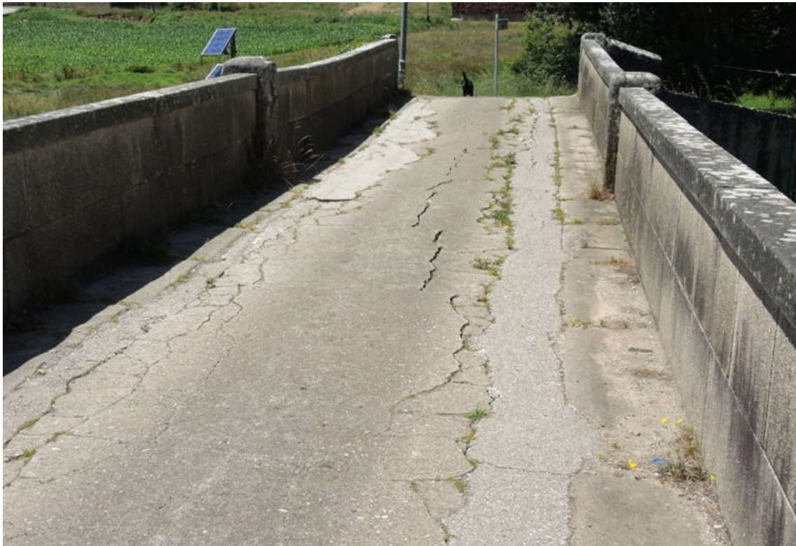
Fotografía 33.- Calzada dañada
