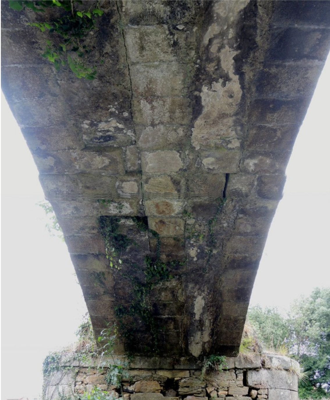
Fotografía 17.- Intradós de la bóveda izquierda
