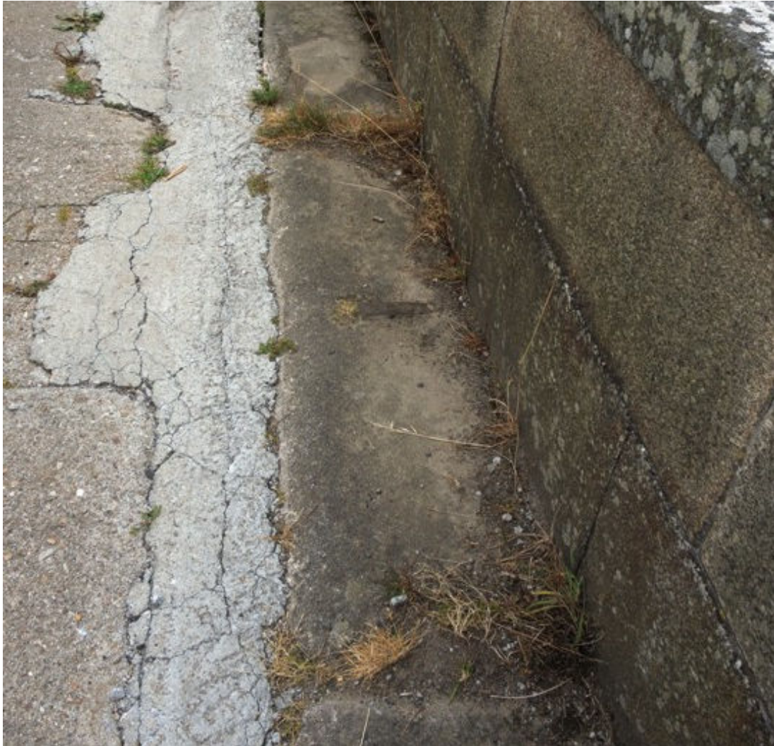
Fotografía 35.- Detalle del anclaje del pretil en las piezas de la cornisa
