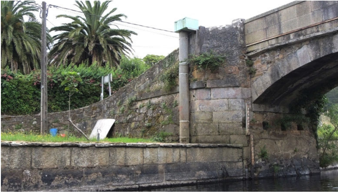
Fotografía 42.- Antigua escala limnimétrica para medición de caudales
