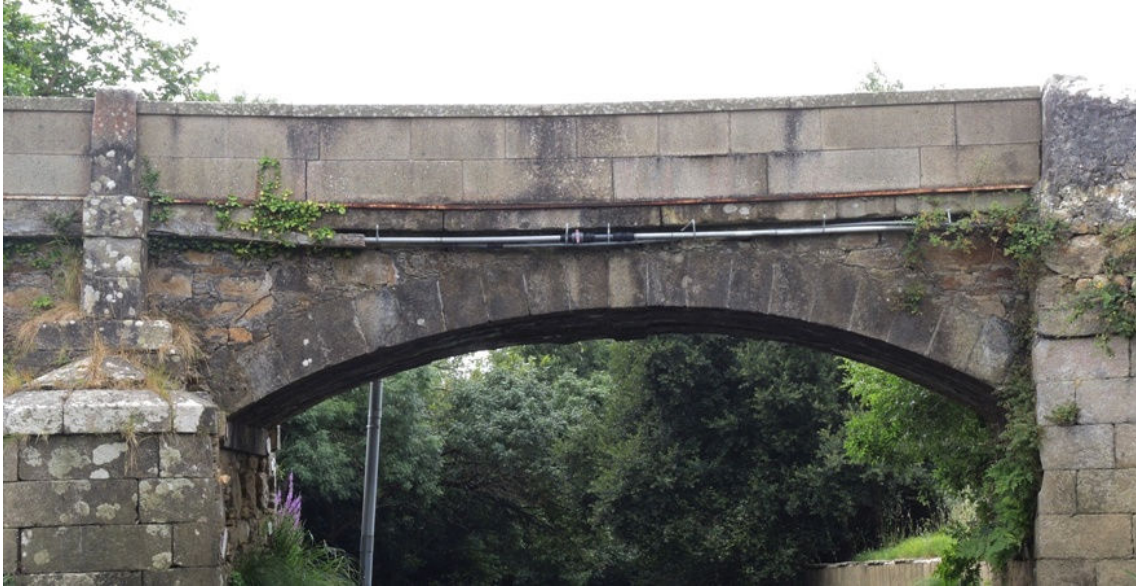
Fotografía 34.- Vista del pretil apoyado en la cornisa
