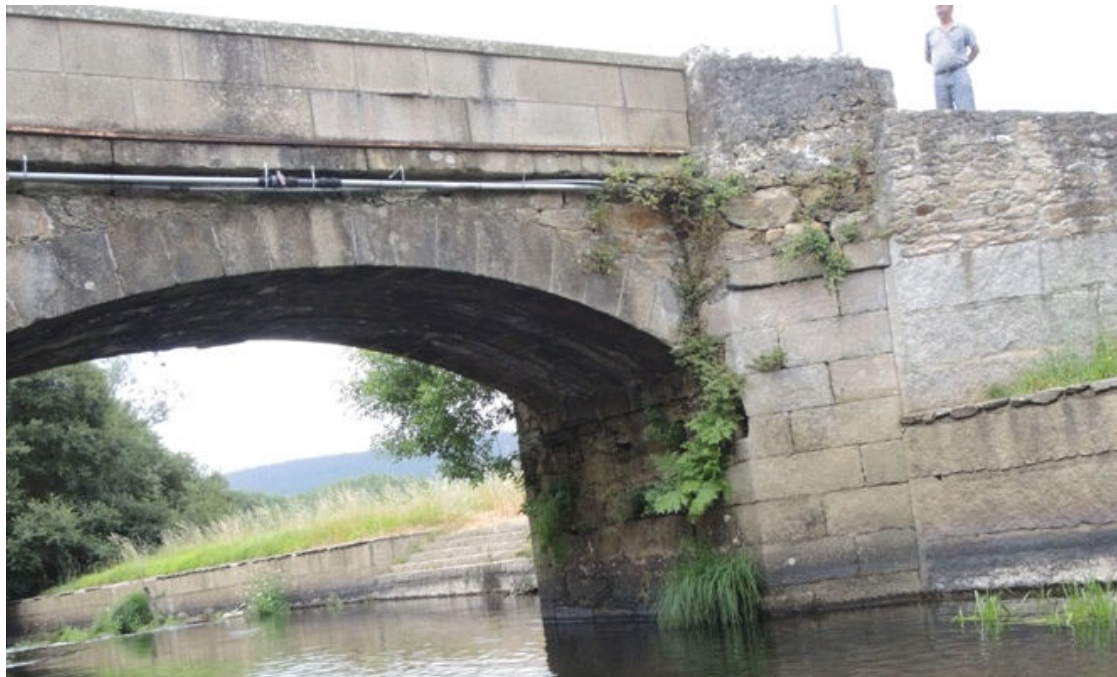
Figura 8.- Vista del estribo derecho aguas arriba
