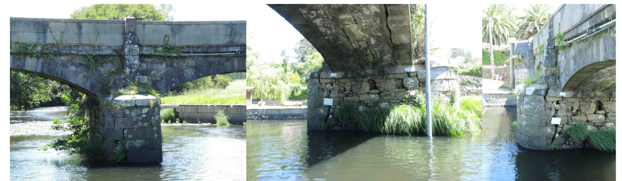
PILA DONDE SE REALIZARÁ LA ENTIBACIÓN
