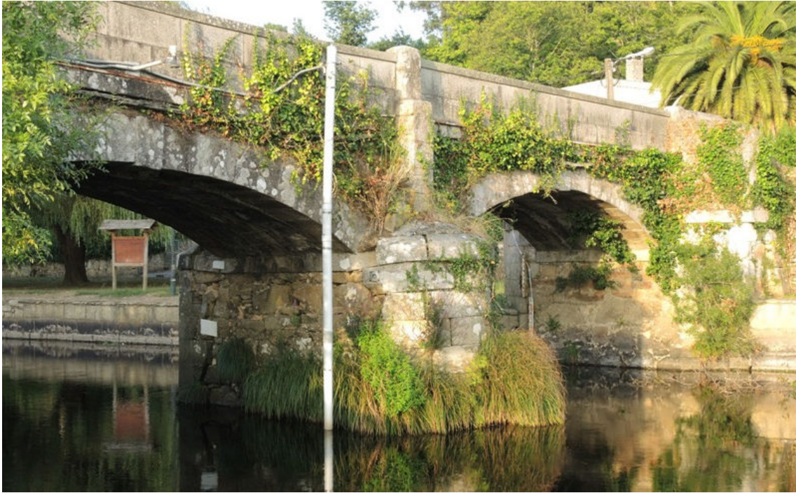
Figura 22.- Medidor de contaminación del lado aguas abajo
