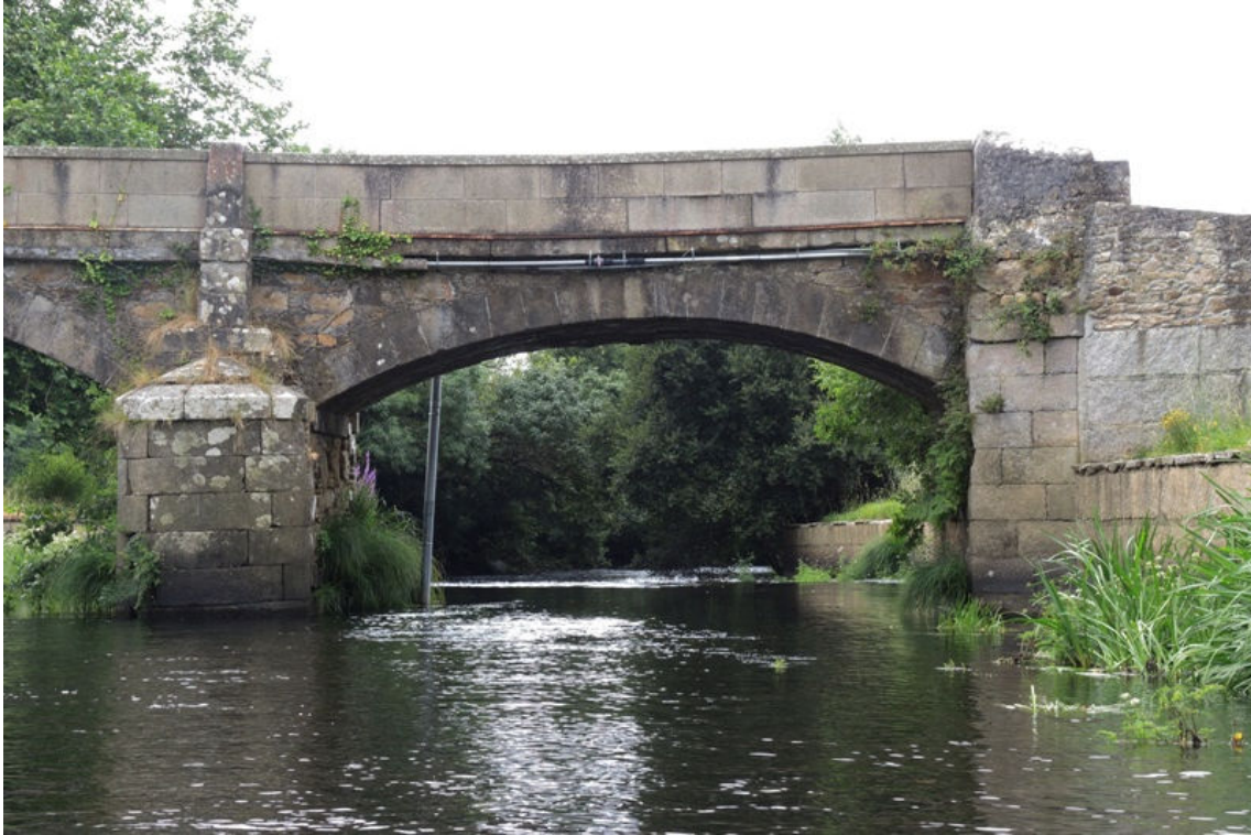
Fotografía 9.- Alzado aguas arriba de la bóveda derecha
