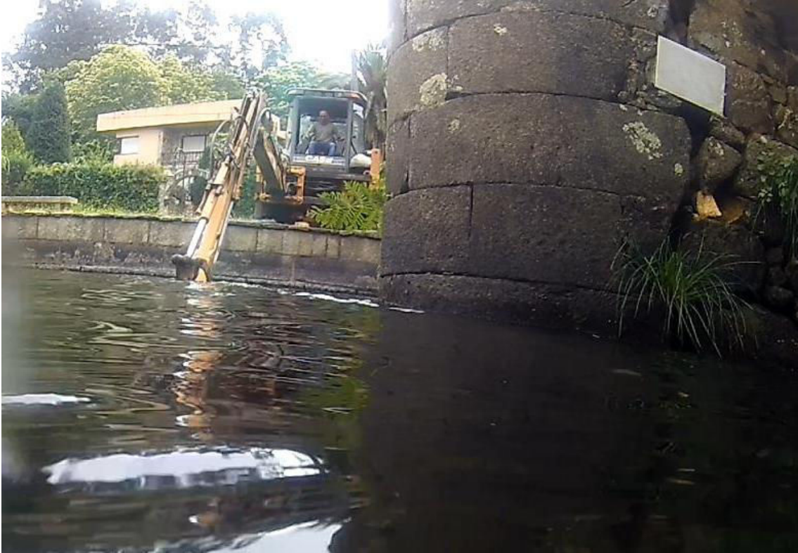
Cata con retroexcavadora en la margen del río
