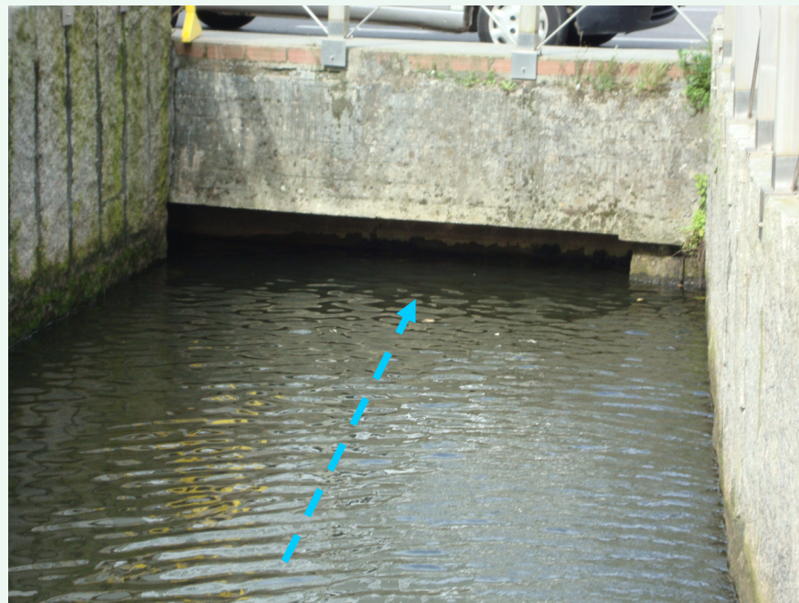
Río Pelamio, a la altura de la Avda. Eduardo Pondal, con marea alta, con sentido Norte de circulación del caudal.
