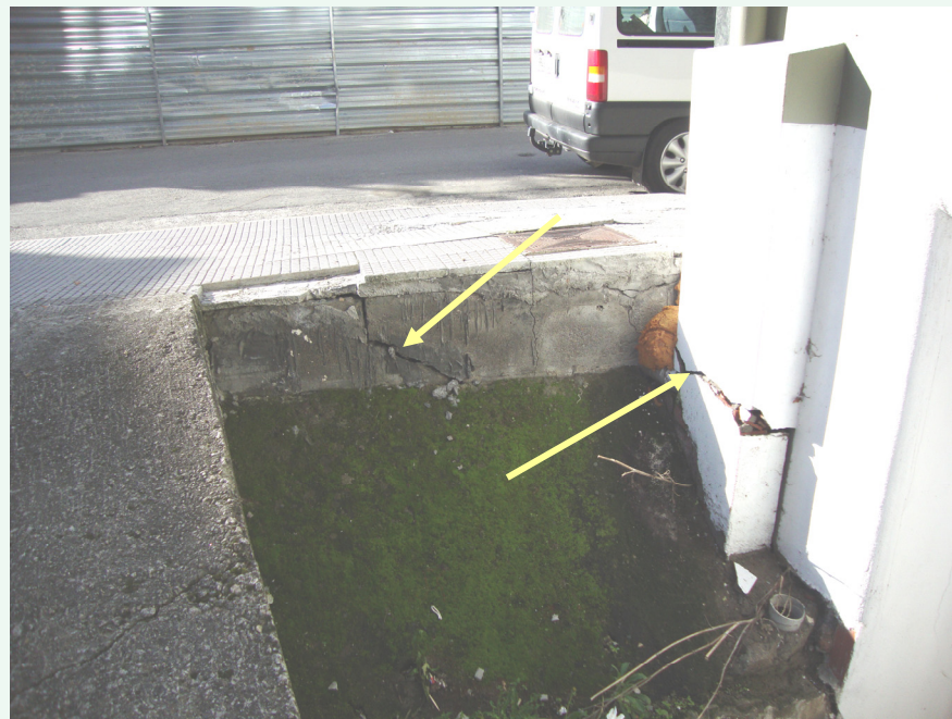
Zona interior de la acera de Travesía Relleno 1, con grietas en hormigón en masa de la solera y en mampostería.
