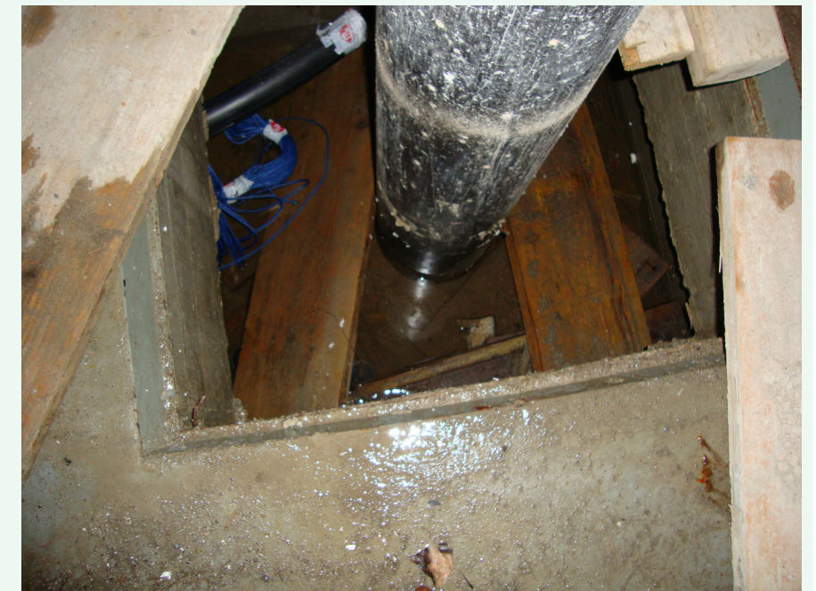
Sótano del edificio de Travesía Relleno. Detalle del pozo de bombeo de la bomba utilizada para permitir los acabados finales del sótano.
