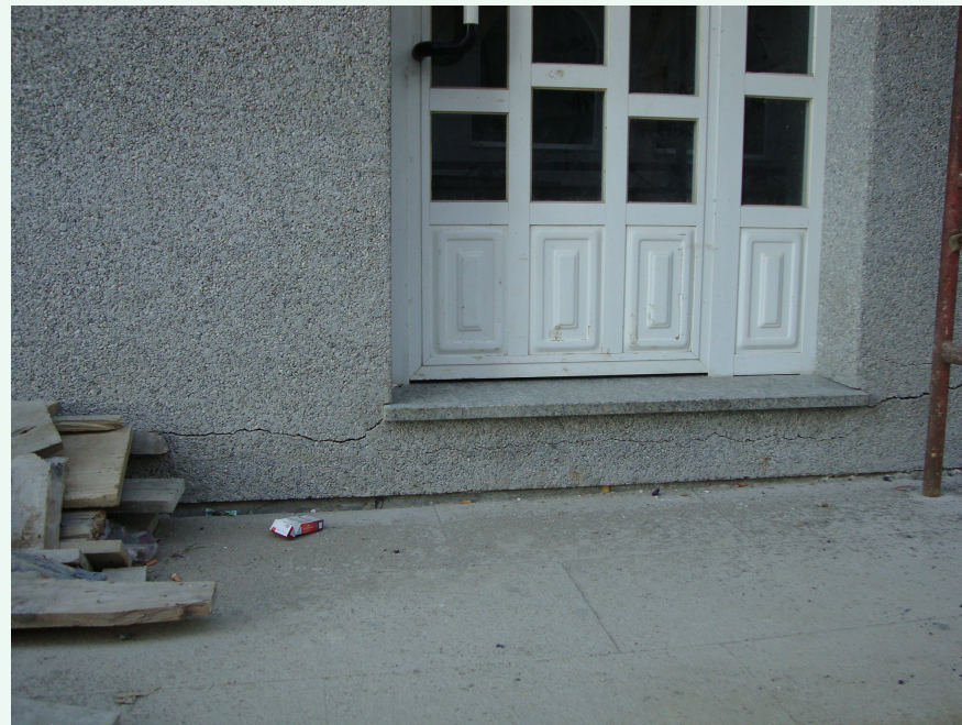
Edificio de Eduardo Pondal 18: grietas en revestimiento del portal.
