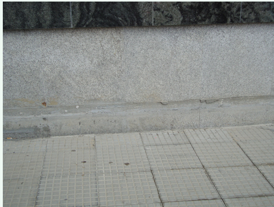
Acera Carnicería. Travesía Relleno
