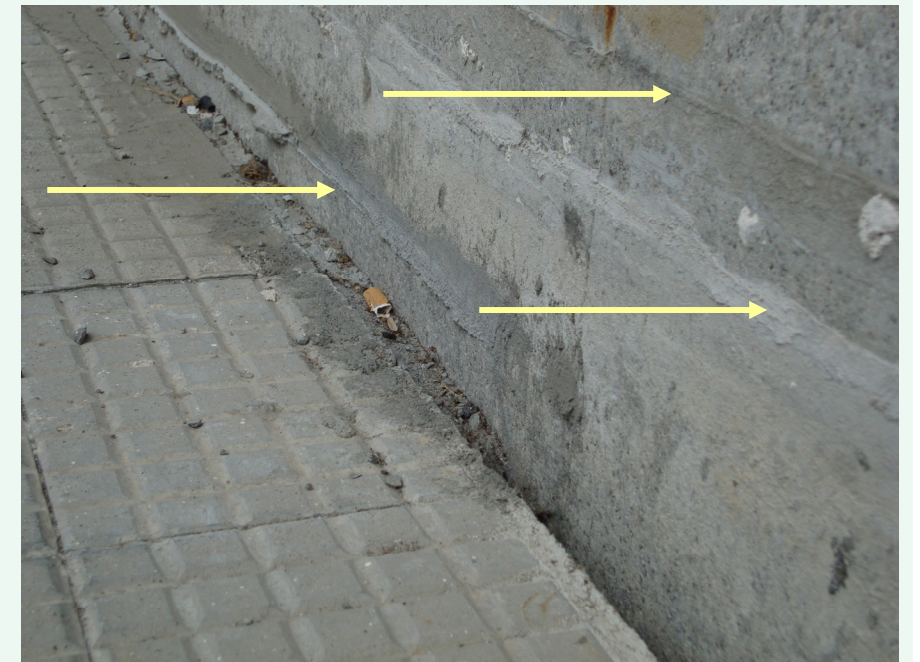
Ídem anterior. Se pueden apreciar los tres asientos que tuvo la acera
