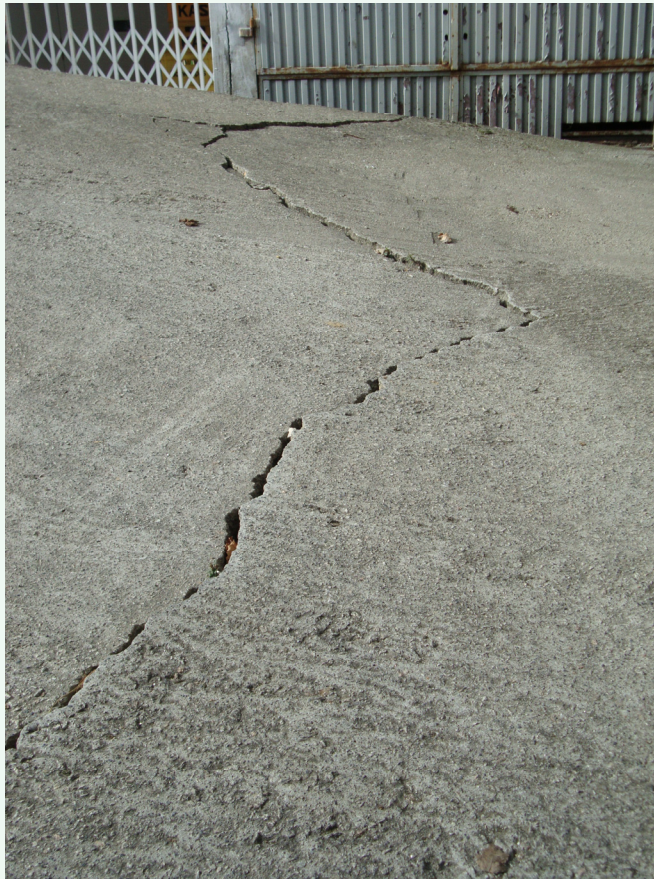
Rampa en Travesía Relleno de acceso vehicular a las traseras de Eduardo Pondal.
