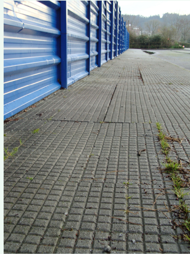
Acera sur de la excavación del solar de Travesía Relleno, en el Paseo Fluvial. No se aprecian hundimientos ni grietas
