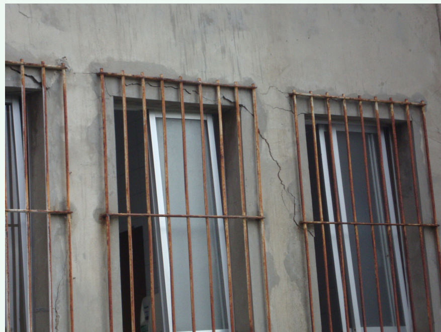
Muro de fachada posterior Banco Gallego. Zona de aseos y almacén
