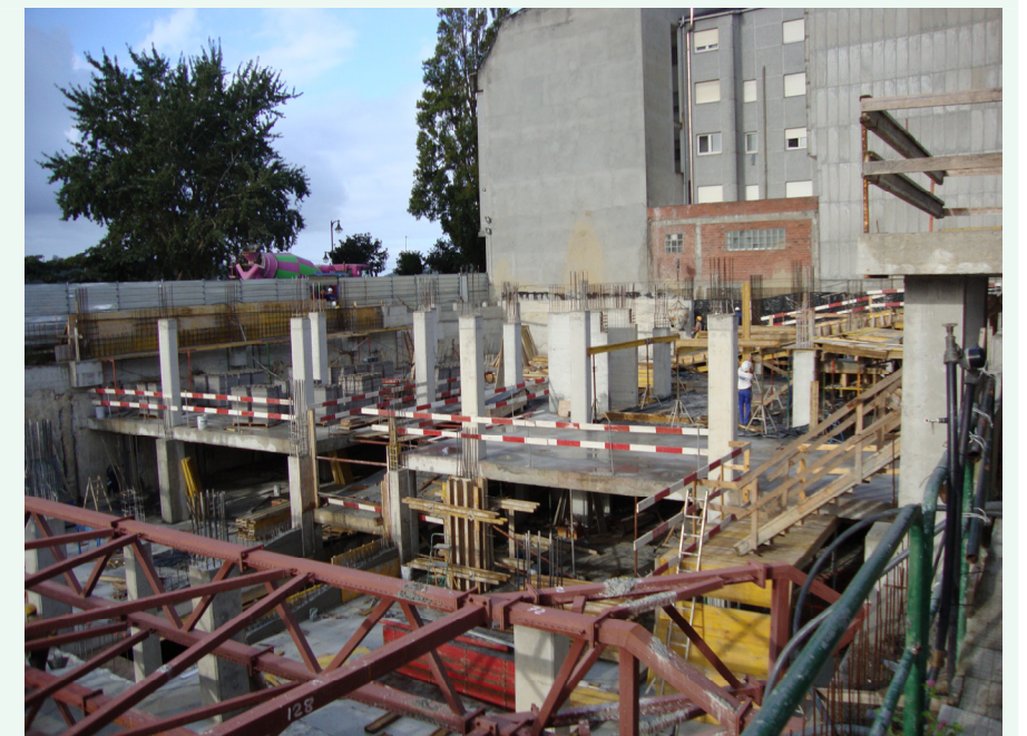
Detalle del forjado de sótano en el solar de la Travesía Relleno, propiedad del Grupo Elyte. Esquina Oeste
