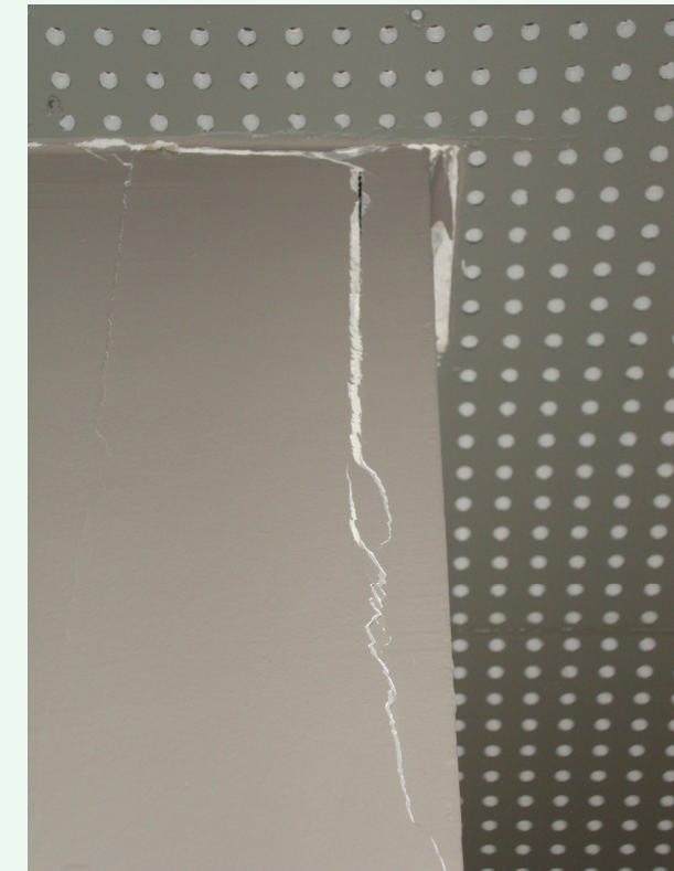
Oficina de La Caixa: muro despacho del Director. Encuentro con el cielorraso
