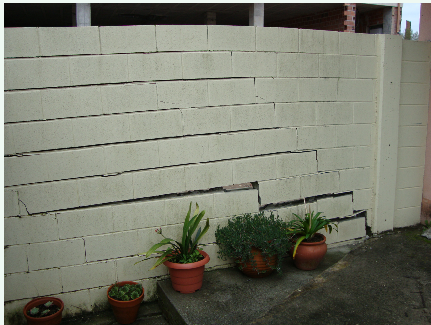
Muro medianero entre las viviendas de Eduardo Pondal 25 y 27
