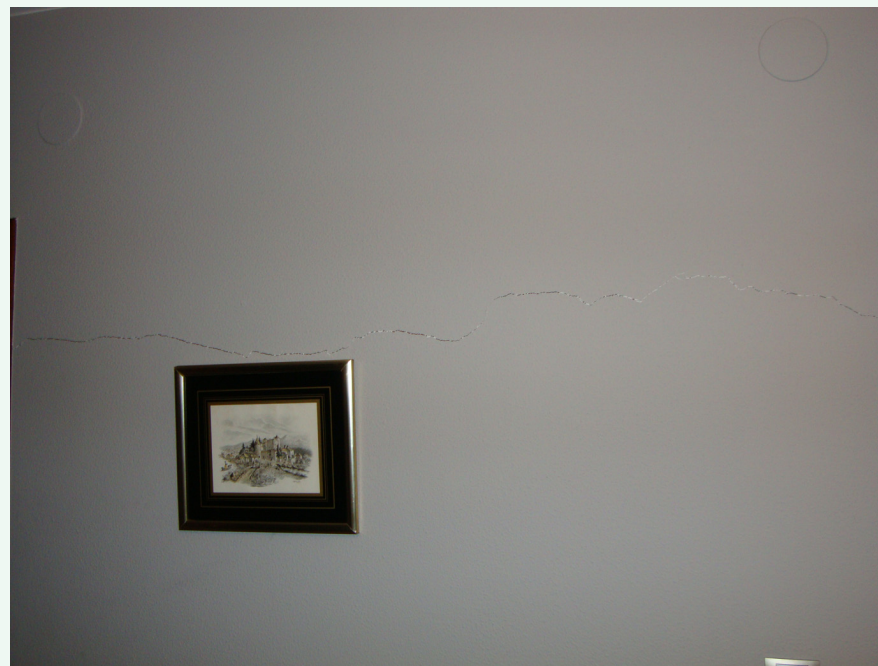
Oficinas de La Caixa: zona sin acondicionar. Detalle de la separación de la estructura del añadido respecto al edificio principal. Muro Este
