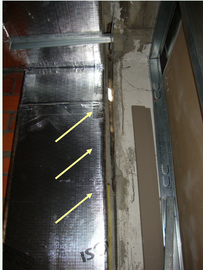
Oficinas de La Caixa: zona sin acondicionar. Detalle de la separación de la estructura del añadido respecto al edificio principal. Muro Este
