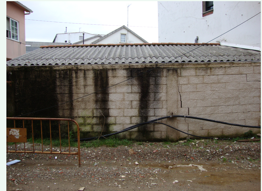
Eduardo Pondal 27, muro exterior sobre vial de nueva ejecución.
