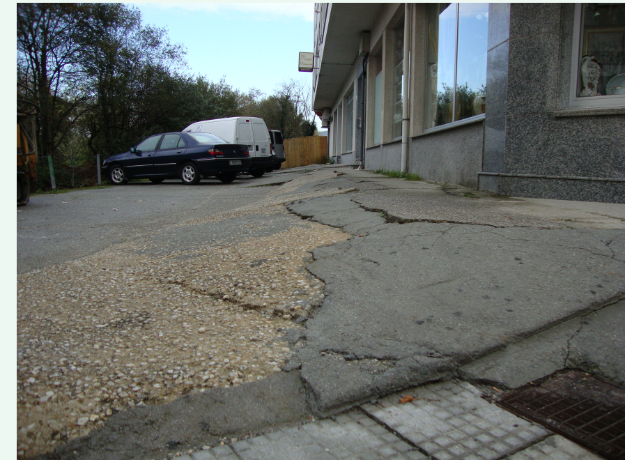
Acera lindero al Rego de los Prados, fachada Oeste del edificio de Eduardo Pondal 19
