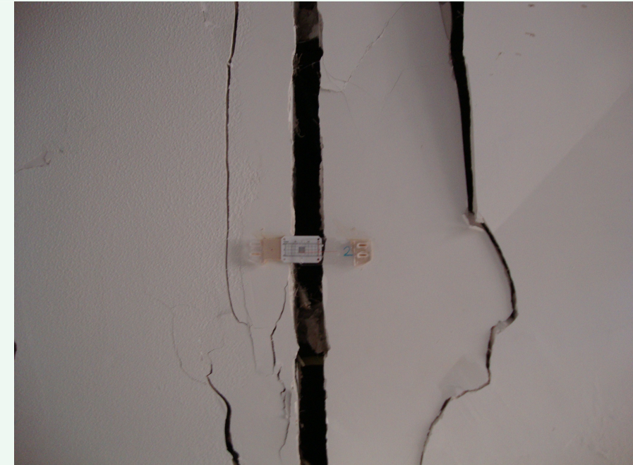
Banco Gallego: fisurómetro nº 2
