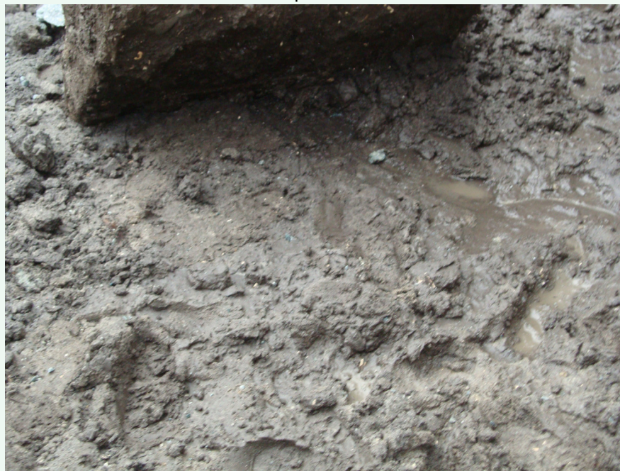
Sótano del edificio de Travesía Relleno. Fangos esquina Este, en la cota final de la excavación.
