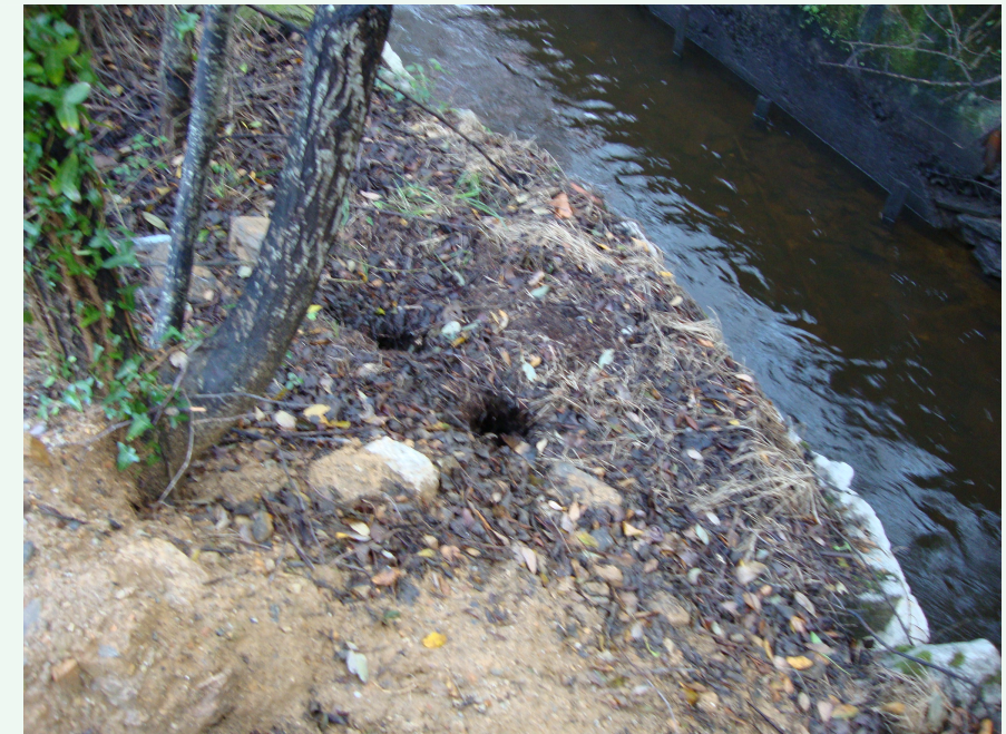
Huella de bota en la ribera del Pelamio en la zona del sondeo 9, que denota la baja calidad de estas.
