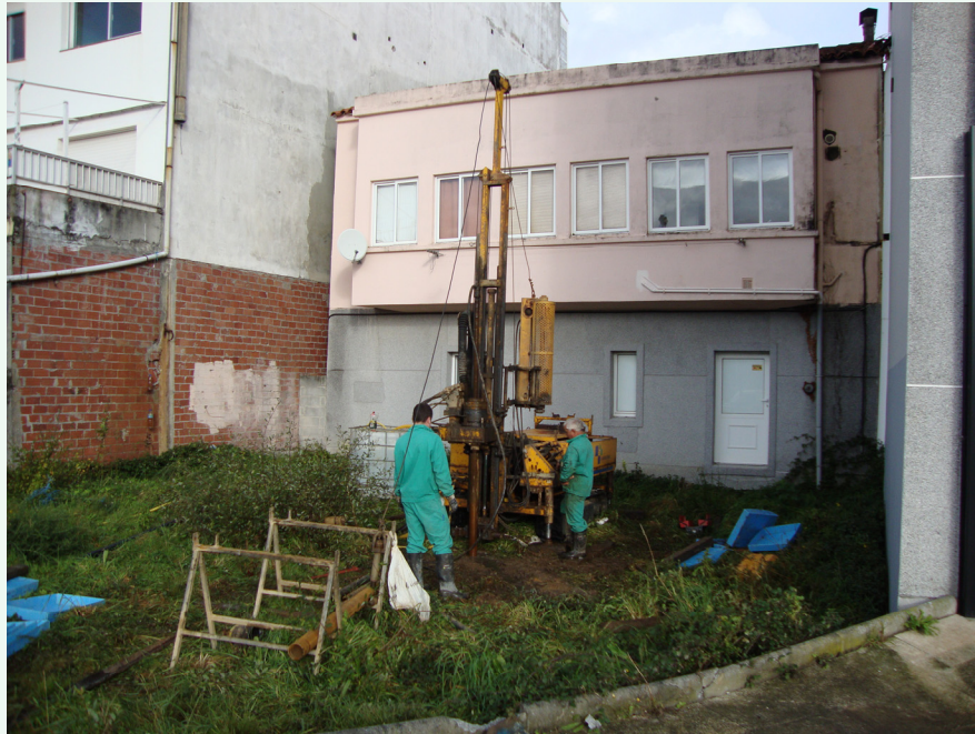
Personal preparando la maquinaria para ejecutar el sondeo 6
