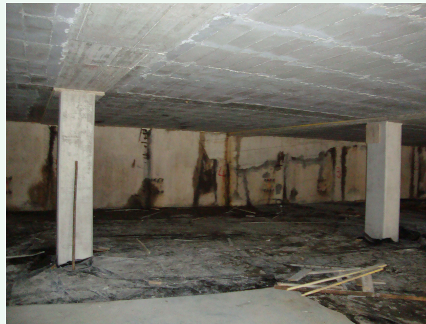
Sótano del edificio de Travesía Relleno. Vista general del 2º sótano.
