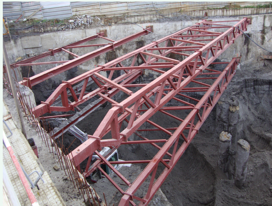
Otra vista de las estructuras metálicas utilizadas como apeos horizontales de la esquina Este.
