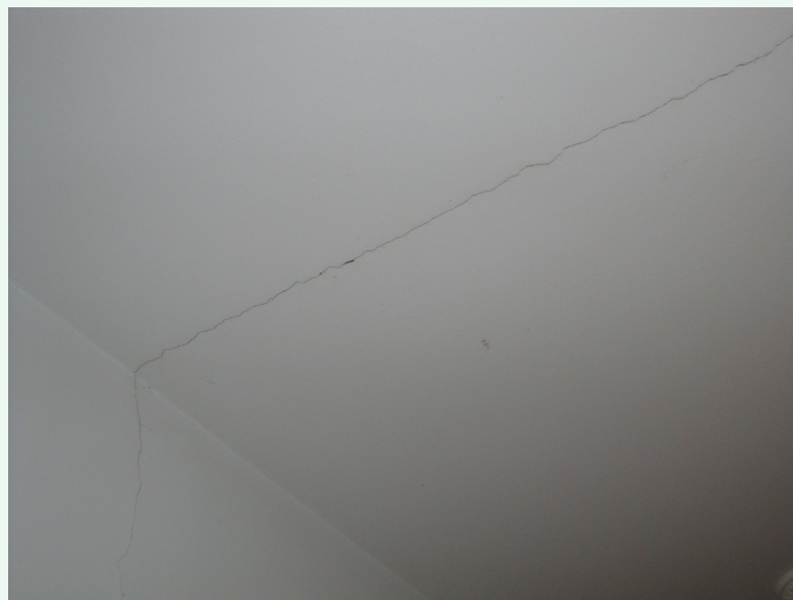
Eduardo Pondal 14, 4º Derecha: fisuras en vivienda.
