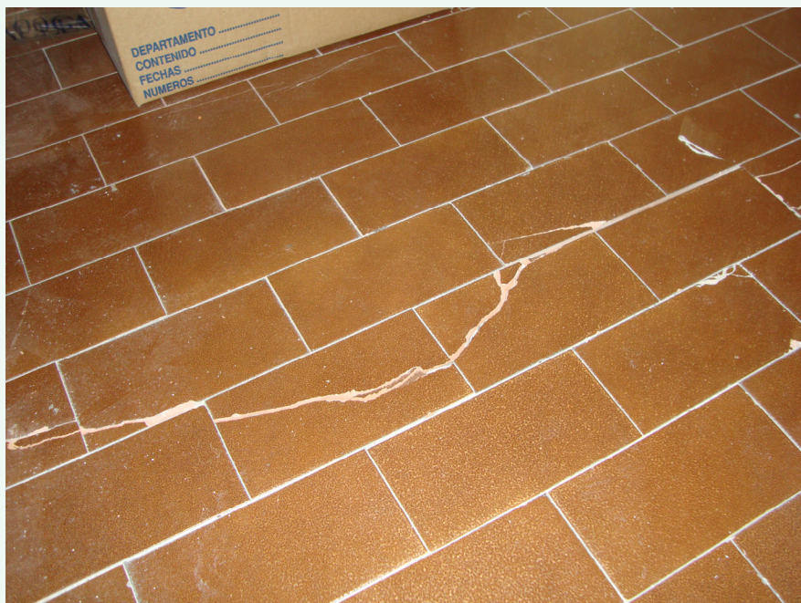
Trasera Banco Gallego. Detalle pavimento almacén
