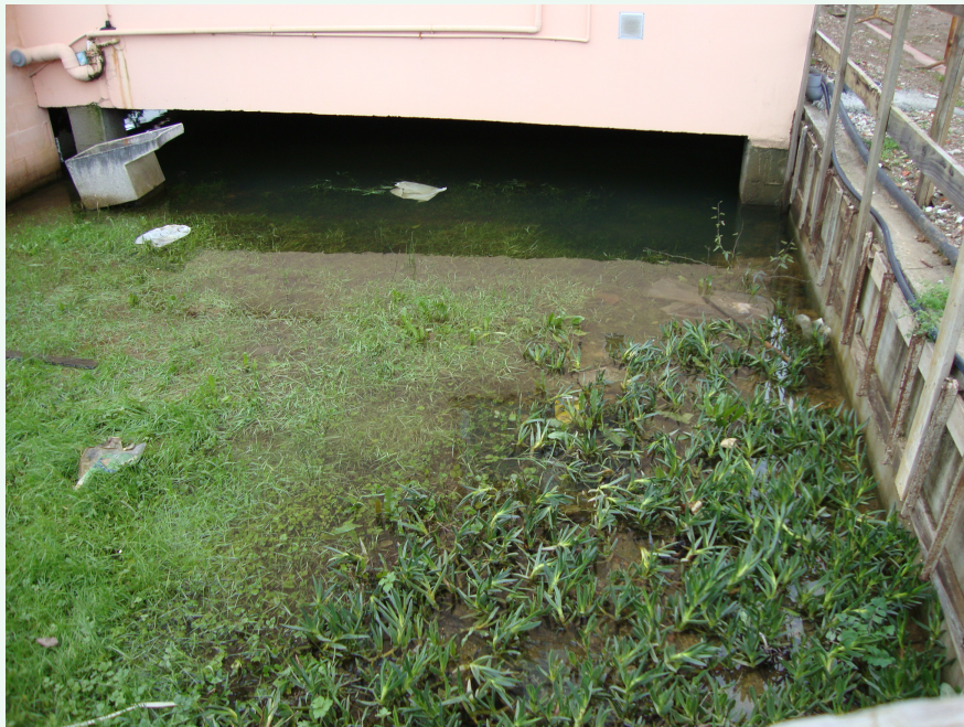
Eduardo Pondal 27, detalle del nivel freático en la cota del sótano
