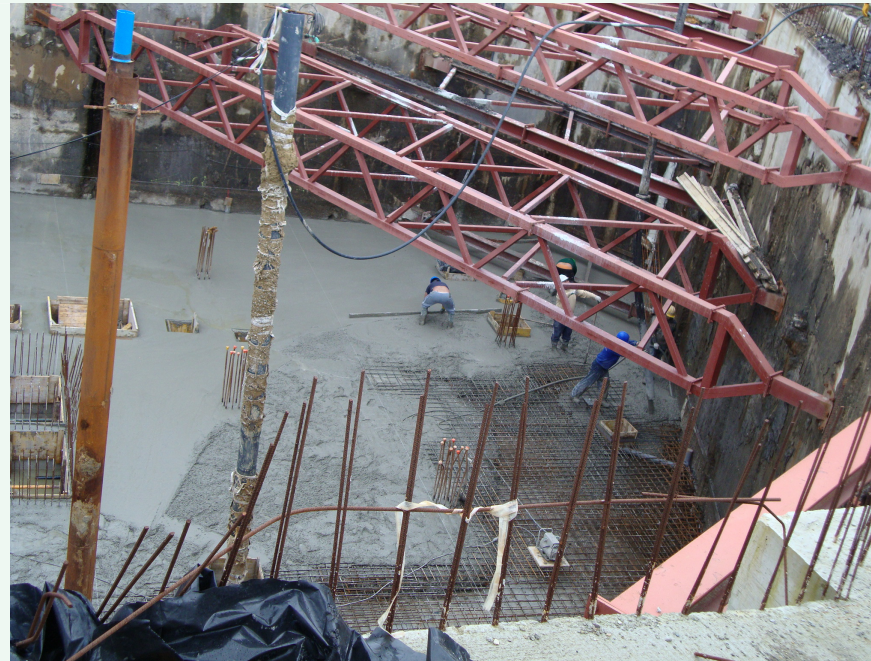
Hormigonado del forjado de sótano en Travesía Relleno
