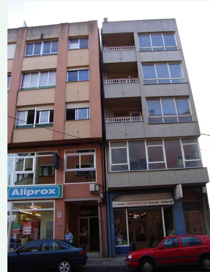
Desplome entre los edificios de Eduardo Pondal 20 y 22
