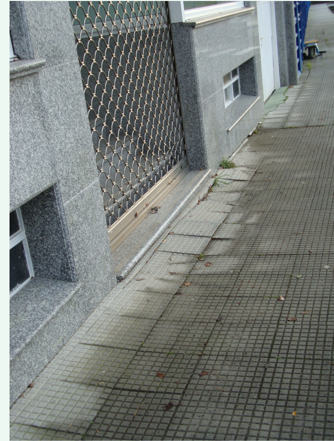
Acera de la Travesía Relleno, edificio lindero con la excavación del solar propiedad del Grupo Elyte
