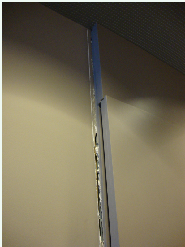
Oficinas de La Caixa: detalle de puerta de acceso a las dependencias traseras de la oficina
