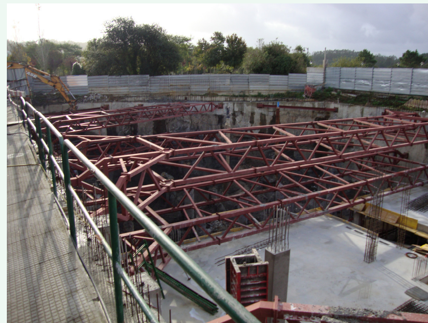
Detalle de los apeos horizontales en las obras del solar de la Travesía Relleno, propiedad del Grupo Elyte. Esquina Este
