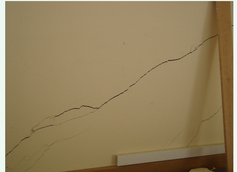
Bajo comercial del Banco Gallego: muro Este
