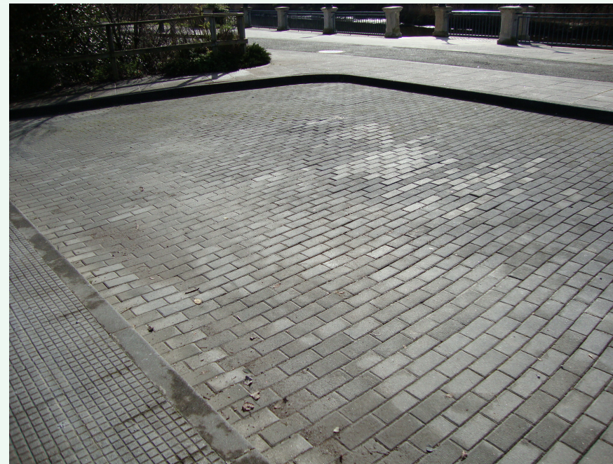
Acera del Paseo Fluvial, detrás de la valla de la obra del Grupo Elyte. No se aprecian fisuras ni hundimientos a pesar de que es zona de estacionamiento de las hormigoneras y bomba.
