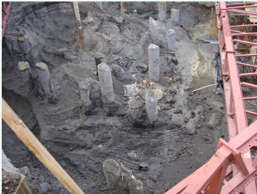
Pilotes en la cota del último sótano, aún sin demoler
