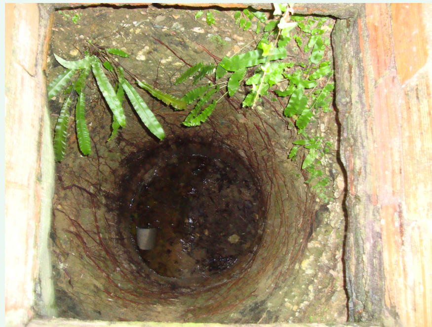
Pozo de agua en el solar donde se encuentra el afluente del Pelamio, actualmente vacío y sin variaciones.
