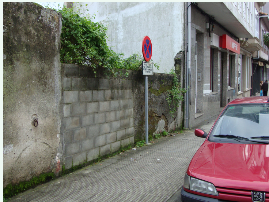
Detrás del muro de bloques se encuentra el antiguo regato afluente del Pelamio, actualmente con caudal dependiente de las precipitaciones
