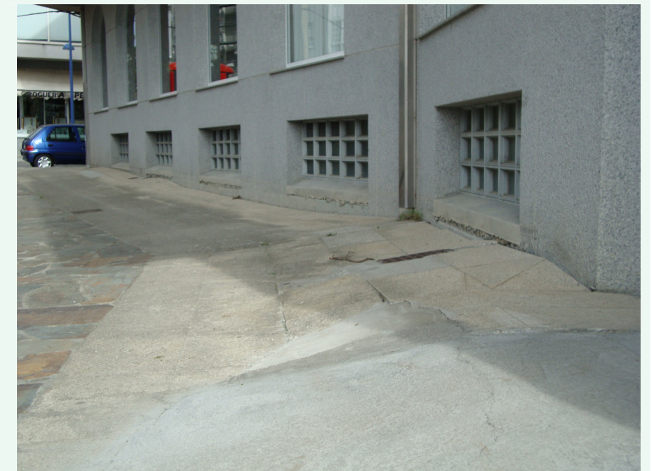
Otra vista de la misma acera Oeste anterior
