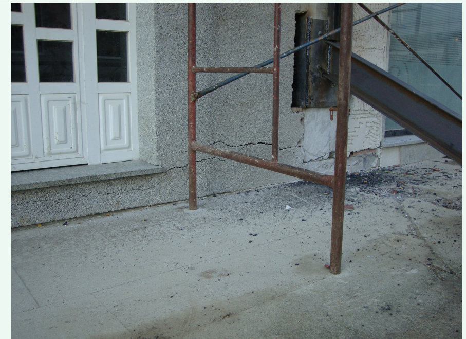
Edificio de Eduardo Pondal 18: grietas en revestimiento del portal.
