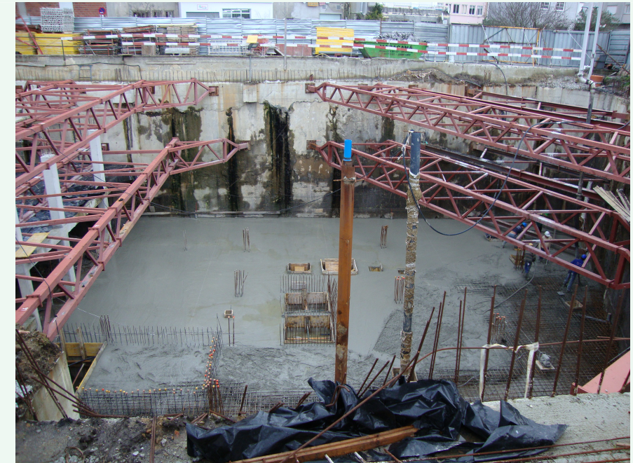
Hormigonado del forjado de sótano en Travesía Relleno
