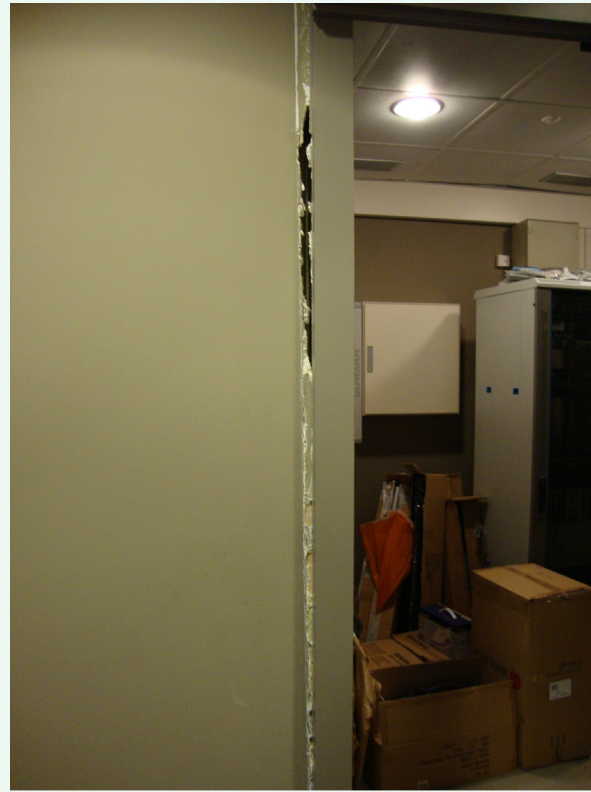
Oficina de La Caixa: muro despacho del Director.
