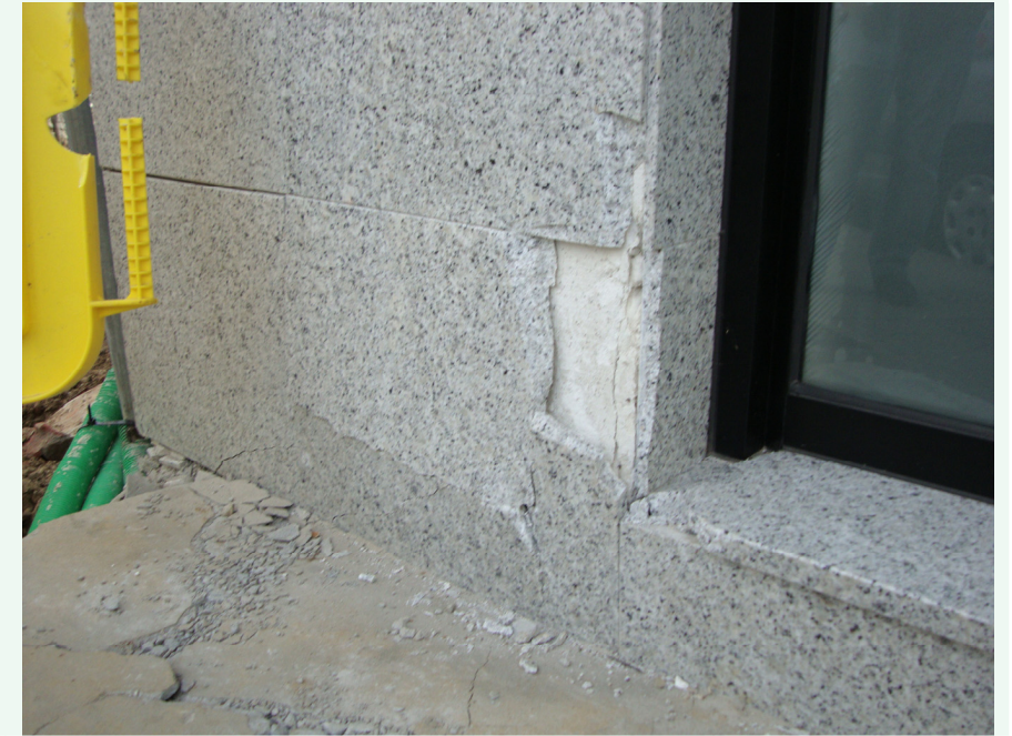
Bajo de Eduardo Pondal 18, fachada Este. Detalle revestimiento de granito.
