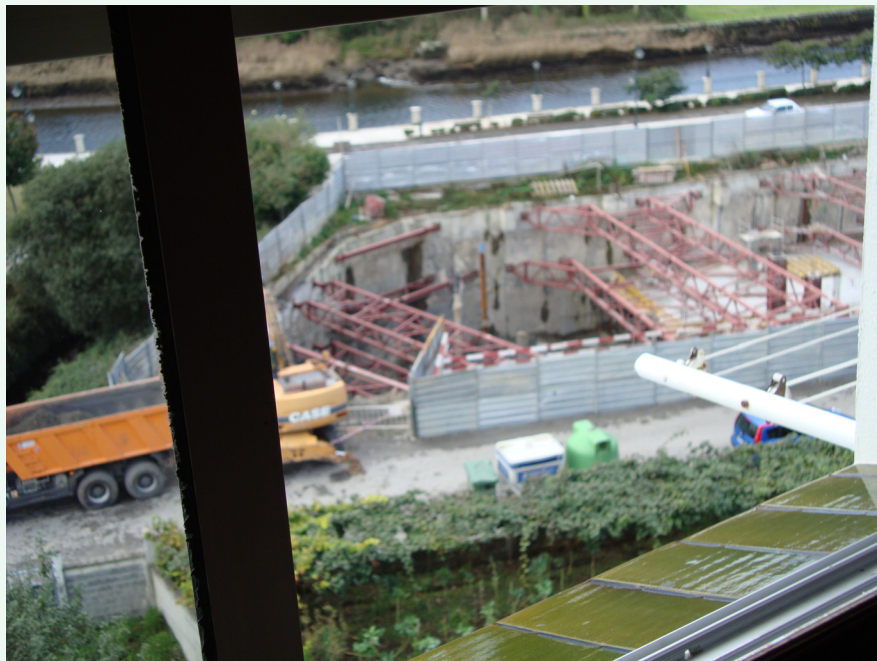
Eduardo Pondal 14, 5º Derecha: vistas a la obra de Travesía Relleno
