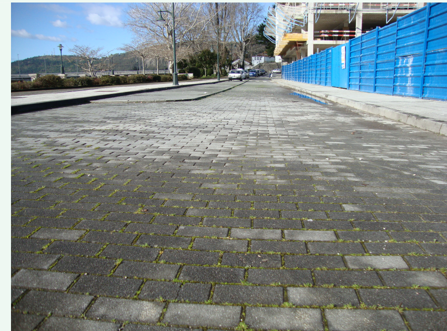
Acera del Paseo Fluvial, detrás de la valla de la obra del Grupo Elyte. No se aprecian fisuras ni hundimientos a pesar de que es zona de estacionamiento de las hormigoneras y bomba.
