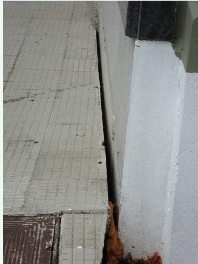
Encuentro acera de al Travesía Relleno con la fachada del edificio del nº 1
