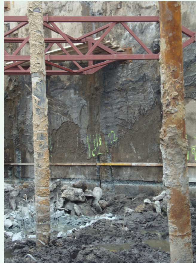
Sótano del edificio de Travesía Relleno. Esquina Este, aun sin limpiar el muro pantalla. En primer plano, dos tuberías de extracción de agua.
