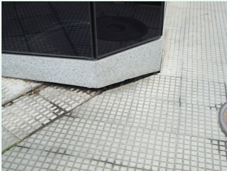
Acera Banco Pastor. Travesía Relleno
