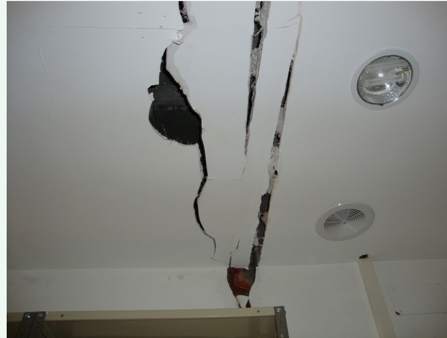
Oficina Banco Gallego: cielorraso de la zona de almacén.
