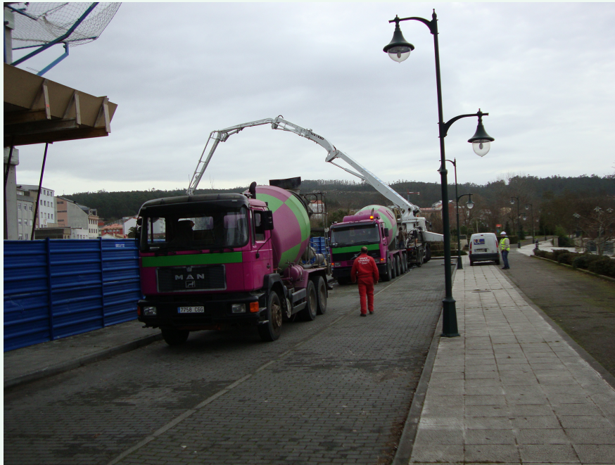
Dos hormigoneras y una bomba estacionados en el Paseo Fluvial, sin producir hundimientos ni grietas.
