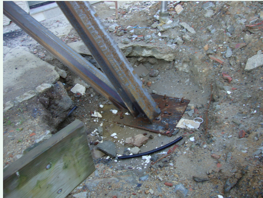
Apuntalamiento del edificio de Eduardo Pondal 18, exterior e interior.
