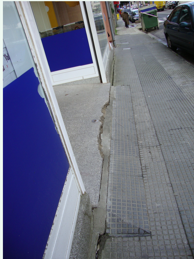
Acera del edificio de Eduardo Pondal 20
