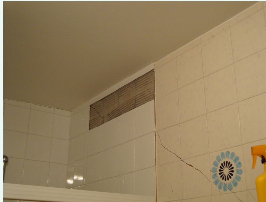
Vivienda de Travesía Relleno 1. Grietas horizontales por esfuerzo de corte y a 45° de tracción.
