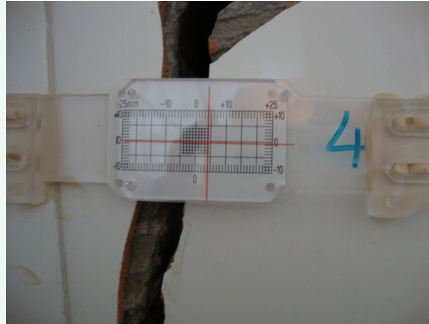
Banco Gallego: fisurómetro nº 4
