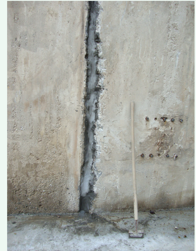
Sótano del edificio de Travesía Relleno. Sellado de un muro pantalla.
