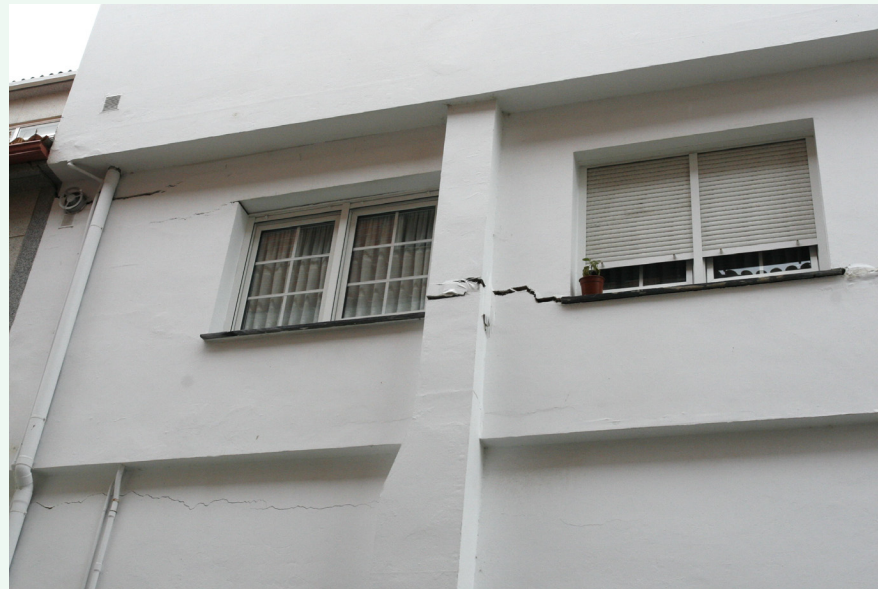
27/08/09: parte trasera de la primera planta del añadido ocupada por una vivienda.
