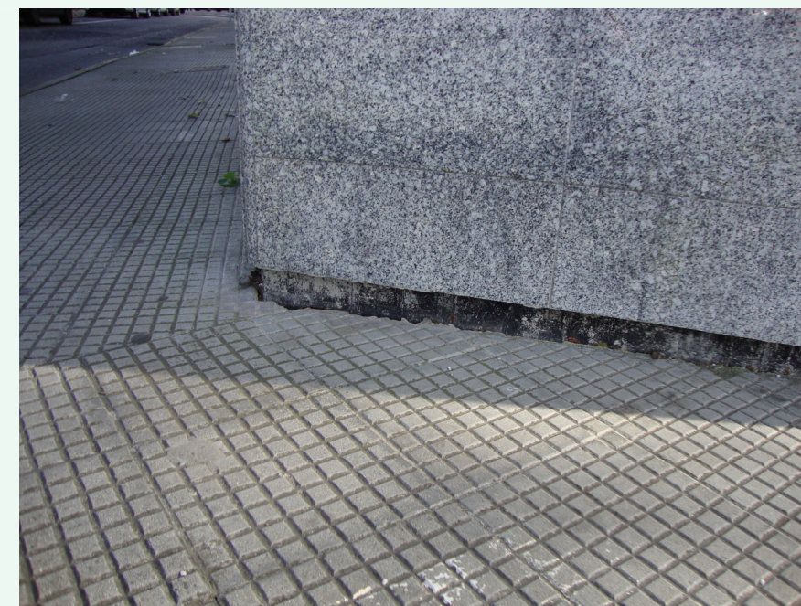
Acera de la esquina del Paseo Fluvial con la Praza do Relleno.
