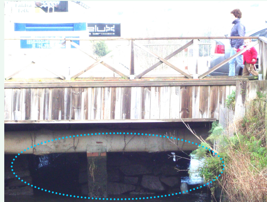
Puente de Eduardo Pondal sobre el río Rego de los Prados. Se puede ver parte de la antigua estructura portante de piedra del vial
