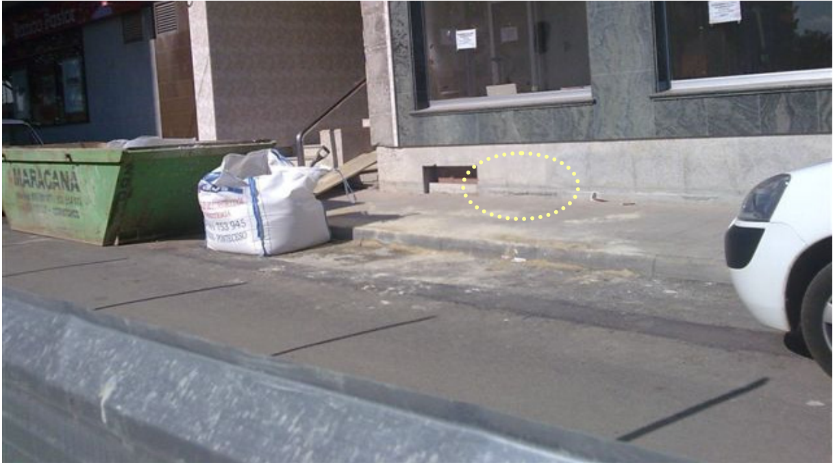
Ídem la foto anterior. Se aprecia el descenso existente en la acera, aunque es difícil de cuantificar. Foto tomada desde el solar antes de finalizar el vallado del mismo.
