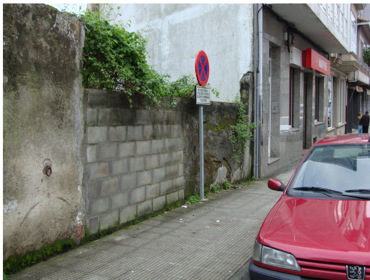
Detrás del muro de bloque, en la avenida Eduardo Pondal 7, se encuentra el solar por el que discurre el “afluente” del Pelamio.
